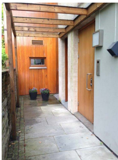
Fig. 43 Øvre bygning har overdekket inngangsparti i tråd med prinsippet om universell utforming. Muren danner en naturlig ledelinje. Inngangsdøren har avfaset terskel.
