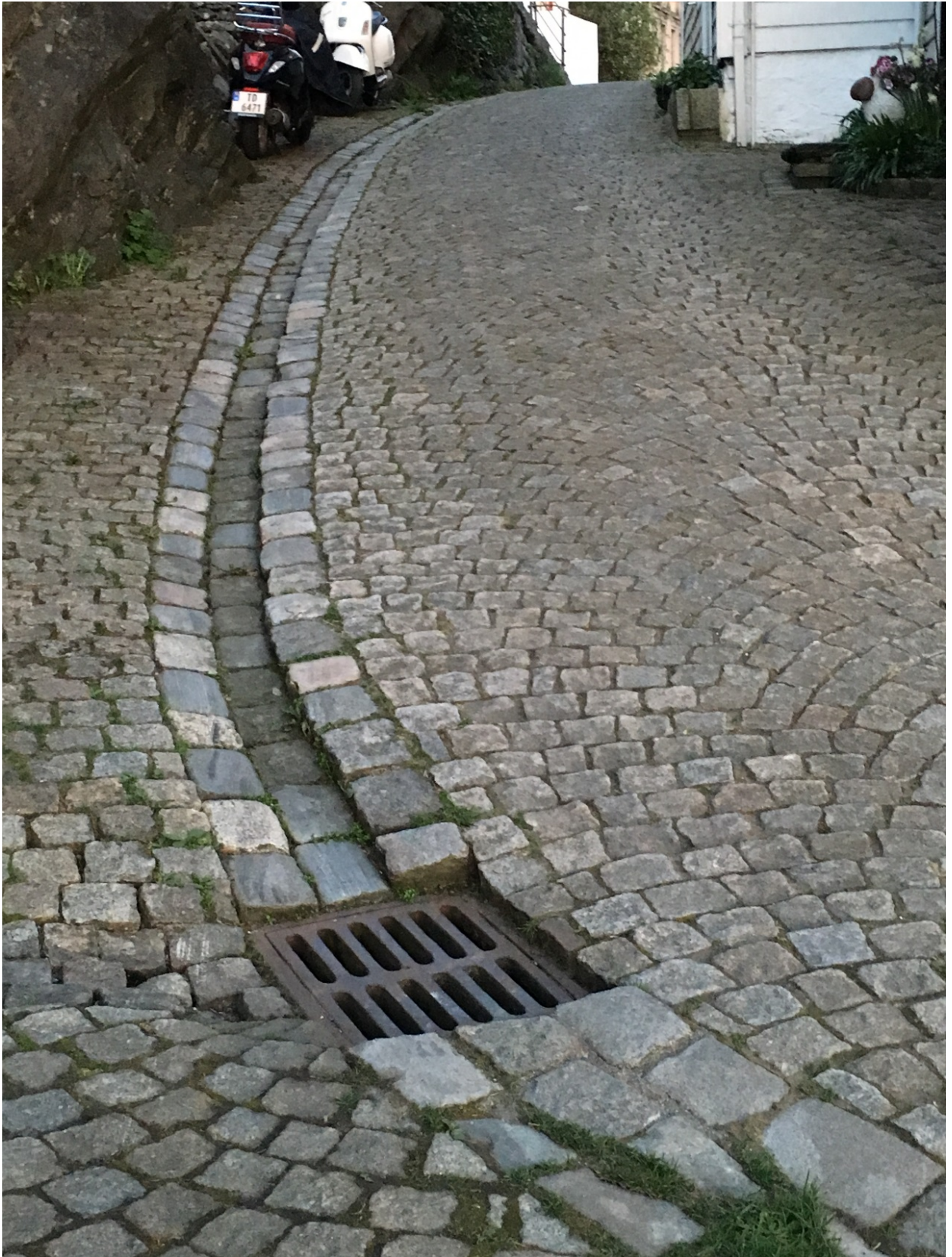
Fra gateløp i Bergen. Overflatevannet føres til en renne med sluk. Løsningen er et viktig visuelt element i bybildet.
