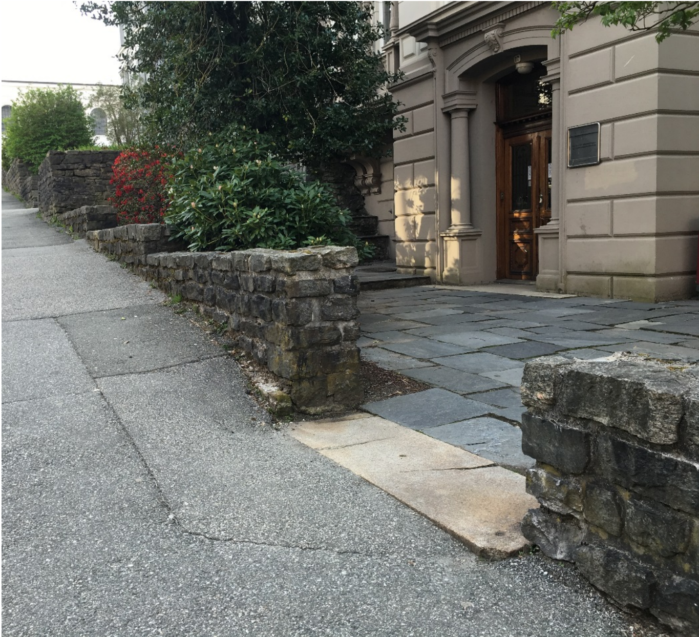
Terrassert inngangsparti i Bergen. En mur formidler overgangen mellom det skrånende fortauet og det plane inngangspartiet.
