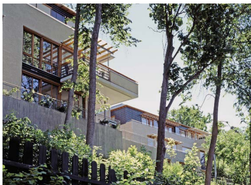
Fig. 38 Støpte murer danner overgangen til terrenget der tomten er brattest.
