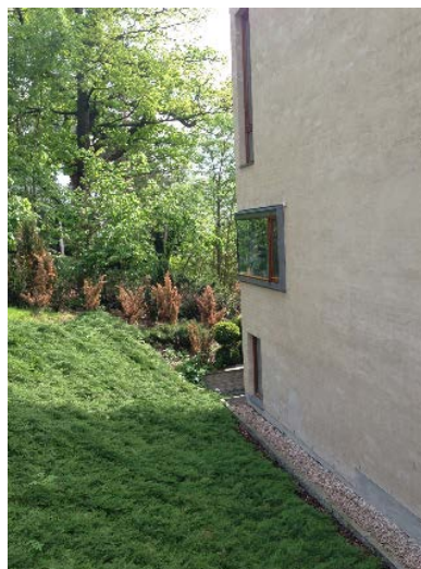
Fig. 44 d Overgangene mellom bygning og terreng har fått særlig oppmerksomhet.
