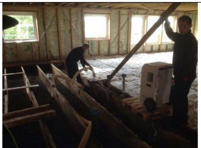
Figur 9. Innblåsing av isolasjon. Foto: Ståle Tranås
