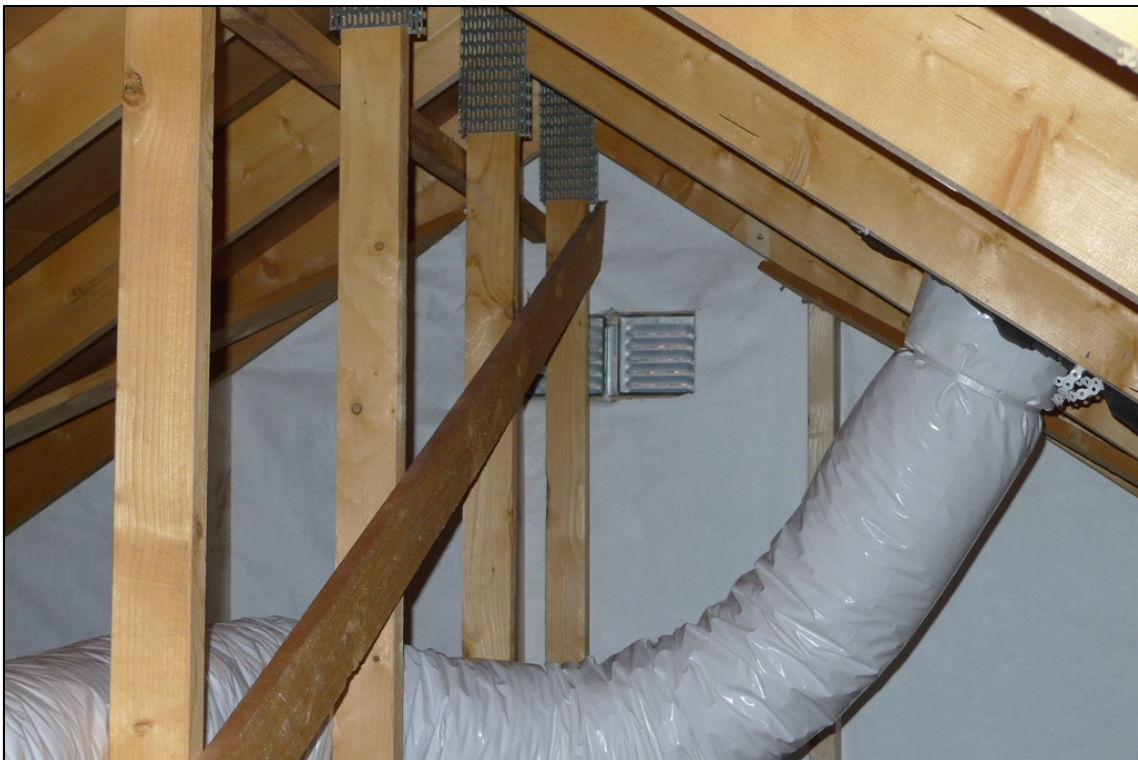
Foto 6 Lufteventiler i gavli i luftet, kaldt loft
