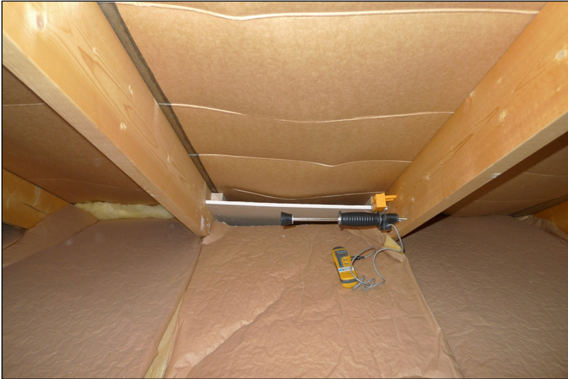
Foto 5 Lufteåpning til kaldt loft ved takfot
