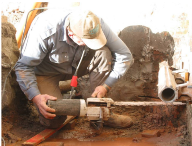
Fig. 2.7.3 Bruk av kjedesag for å etablere vanntett horisontalt sjikt. Her er det vist en håndholdt variant, men de er også benyttet på forskjellige former for rigger avhengig av størrelsen på sagen. Foto: (GI, 2006)
