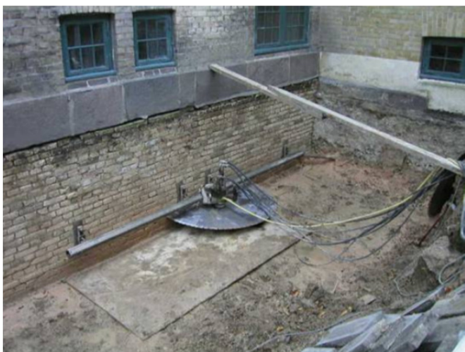
Fig. 2.7.2 Bruk av sirkelsag for å etablere vanntett horisontalt sjikt. Foto: (Østergaard og Hansen, 2003).
