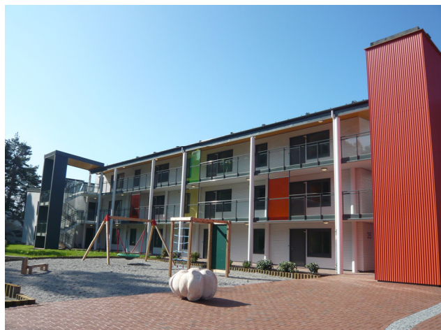
Figur 1.2 I prosjektet Løvåshagen i Bergen er det bygd boliger med lavenergi-standard og passivhus. Foto: SINTEF Byggforsk
