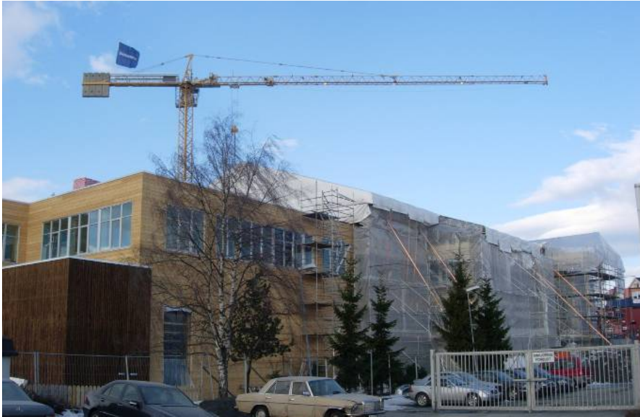
Figur 6.1 Skolebygg i Trondheim under oppførelse under full værbeskyttelse. Med økt isolasjonstykkelse blir det viktigere å unngå at konstruksjonene fuktes opp under bygging, og bruk av teltsystemer eller planlagte lokale tildekninger er mulige tiltak. Foto: SINTEF Byggforsk.
