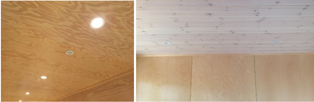
Figur 31 og 32. Innfelt downlightbelysning i finertak (til venstre) og i trepanel i taket (til høyre) Foto: SINTEF Byggforsk
