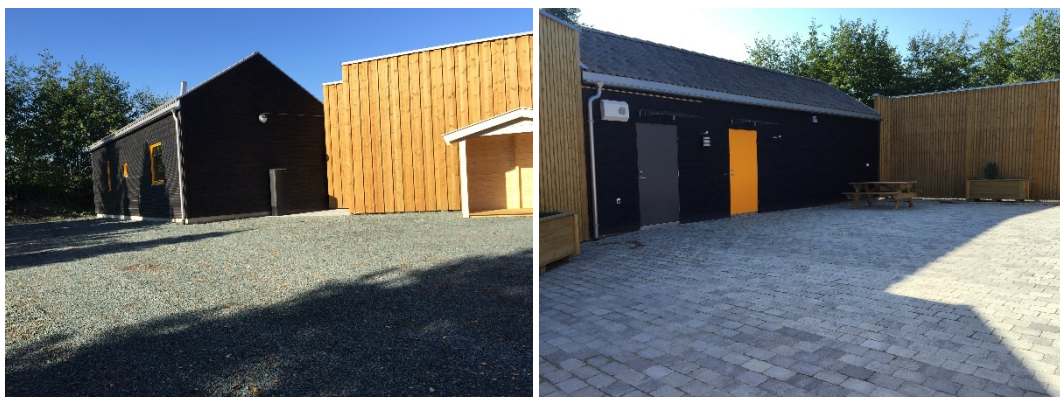
Figur 19 og 20. Inngangen og gårdsplassen til pilotbygningene på Mælabakken. Foto: SINTEF Byggforsk
