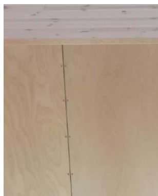
Figur 30. Åpen skruing av finerplater forenkler demontering. Unngå bruk av listverk. Foto: SINTEF Byggforsk
