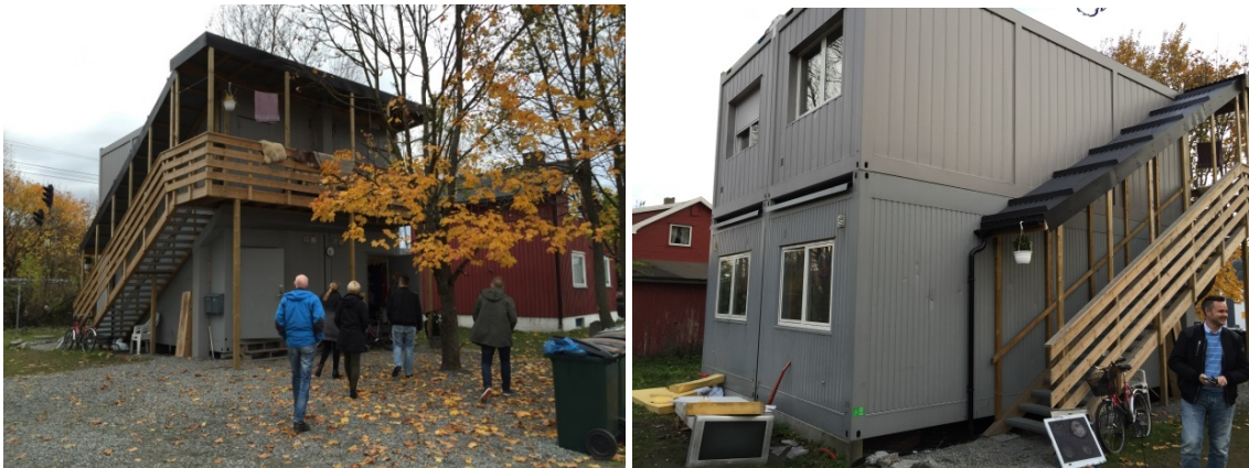
Figur 3 og 4. Midlertidige boliger, Mjøndalen. Foto: SINTEF Byggforsk
