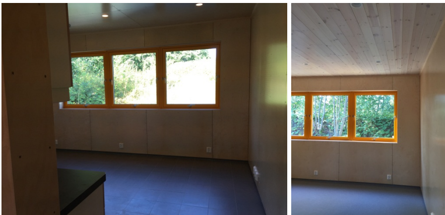
Figur 33 og 34. Oppholdsrom, Mælabakken, med ulike materialvalg på gulv og tak Foto: SINTEF Byggforsk
