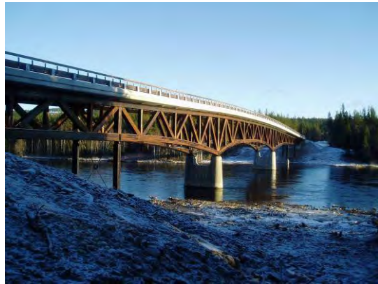
Bilde 30. Bro med limtre Foto: Moelven Industrier ASA
