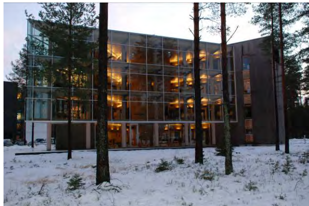
Bilde 26. Viken skog- bygget- nærmere 500 m3 massivtreelementer i gulv, vegg, tak og fasadeelement. Foto: Kjersti Folvik
