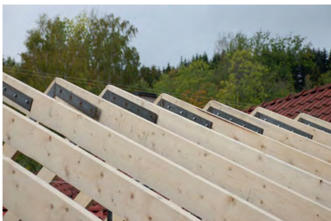
Bilde 15. Konstruksjonslast på byggeplass, her brukt som takstoler Foto: Treteknisk
