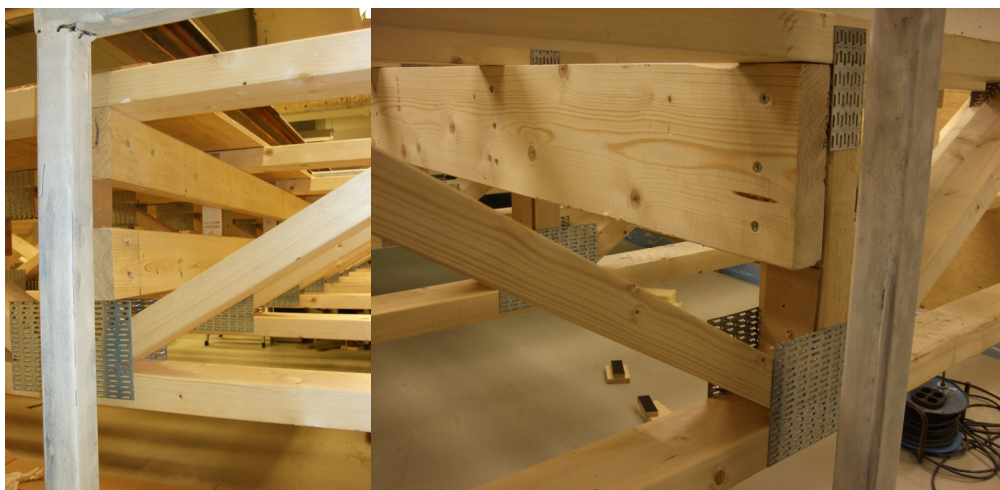
Figur 7.3 To varianter tverravstiving i Gitterbjelkelag
