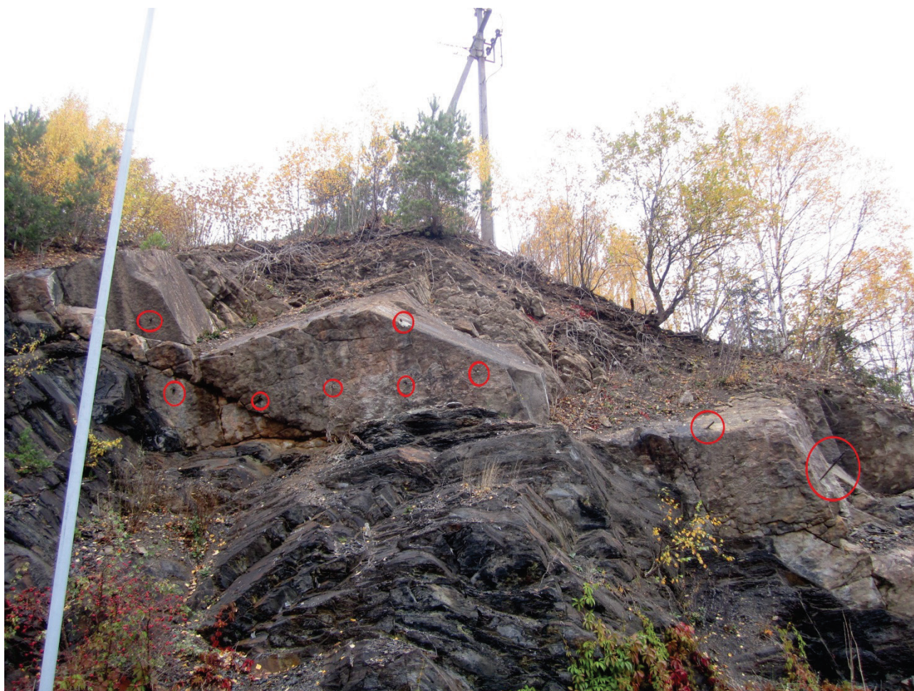
Figur 7: Blokker sikret med stag, stagene er markert med rød ring
