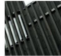
UTVENDIG KLEDNING TREPANEL, TRYKKIMPREGNERT OG KOKT I LINOLJE
