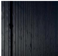
UTVENDIG KLEDNING TREPANEL, TRYKKIMPREGNERT OG KOKT I LINOLJE
