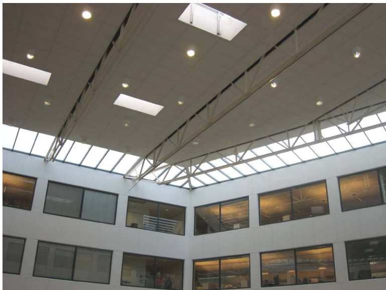
Figur A-8. Tak og vinduer over atriet. (Foto: SINTEF Byggforsk/ Jørn Stene)
