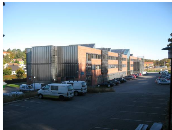
Bravidahuset sett fra syd. Langfasade mot øst og sydfasade dekket med solfanger. Parkeringsplasser ligger utenfor bygget (Foto: SINTEF Byggforsk/ Matthias Haase)
