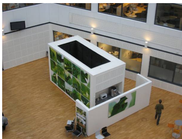
Figur A-16 Vindusåpninger for utstrømning av avtrekksluft gjennom tekjøkken i hver etasje samt avtrekksjakt plassert på gulvet i atriet. (Foto: SINTEF Byggforsk/ Jørn Stene)
