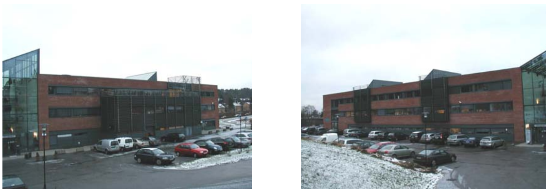
Figur B-9. Fasade øst. Venstre bilde: Nordfløy. Høyre bilde: Sydfløy (Foto: SINTEF Byggforsk/ Catherine Grini)
