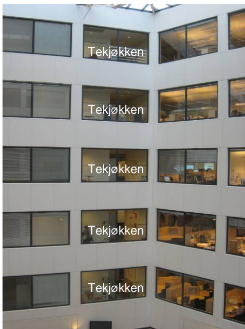
Figur A-16 Vindusåpninger for utstrømning av avtrekksluft gjennom tekjøkken i hver etasje samt avtrekksjakt plassert på gulvet i atriet. (Foto: SINTEF Byggforsk/ Jørn Stene)
