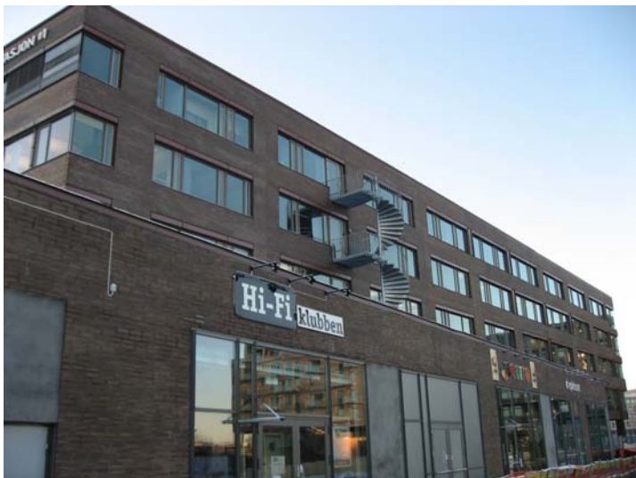
Figur D-8. Nordfasaden (Foto: SINTEF Byggforsk/ Matthias Haase)
