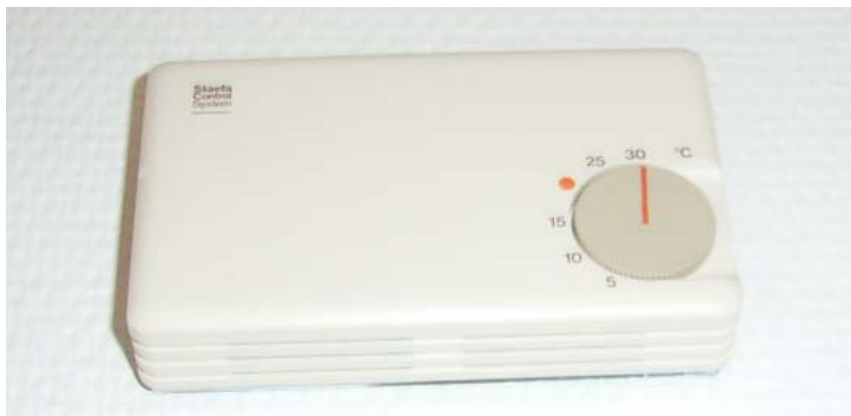
Figur E-8. Temperaturregulator på kontorene av typen Eberle 172257201. Vær oppmerksom på at skalaen er misvisende.
