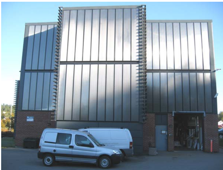
Figur B-7. Fasade syd med solfangere (Foto: SINTEF Byggforsk/ Matthias Haase)
