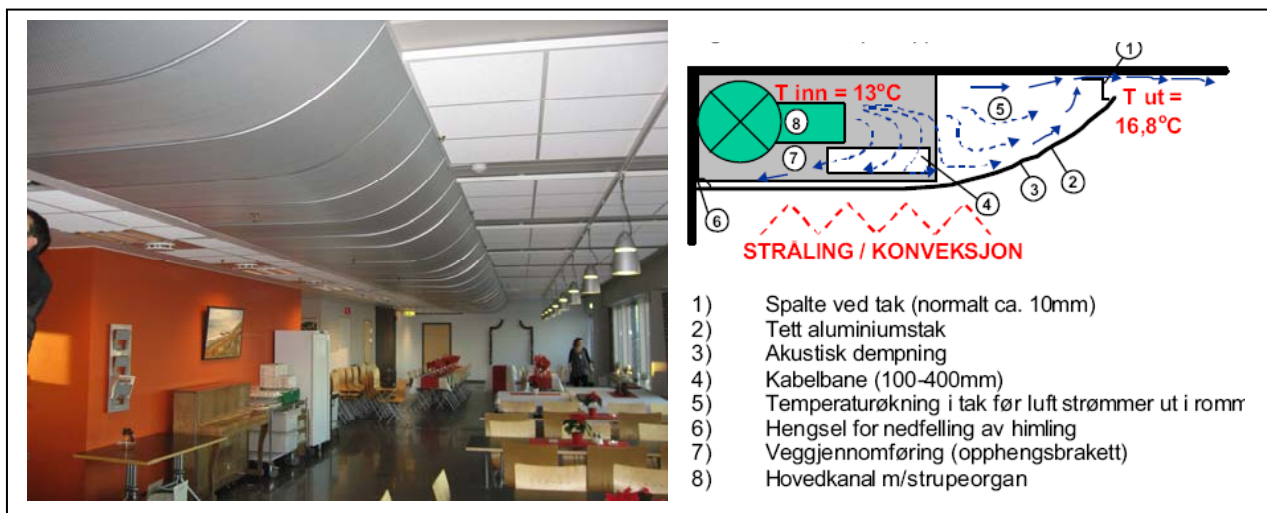
Figur D-6. Klimatak i kantine, bilde og prinsippskisse (Foto: SINTEF Byggforsk/ Matthias Haase)
