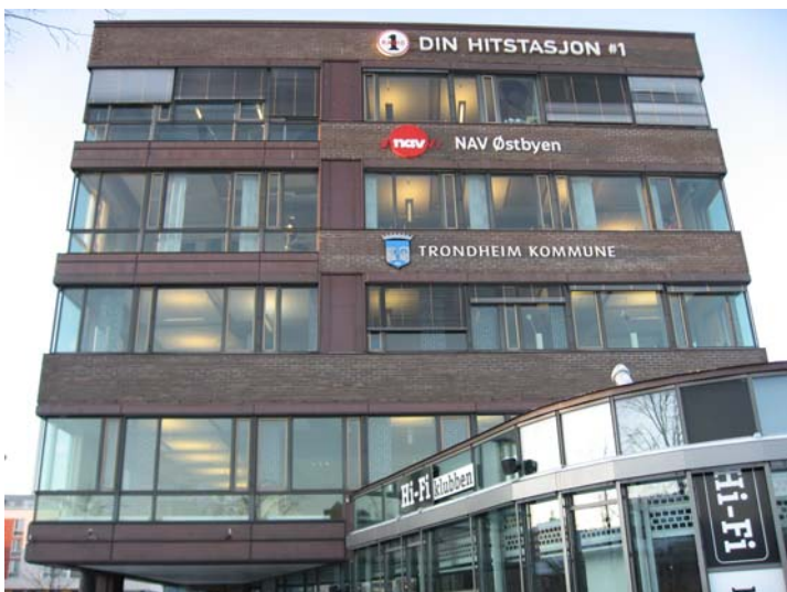
Figur D-10. Østfasaden (Foto: SINTEF Byggforsk/ Matthias Haase)
