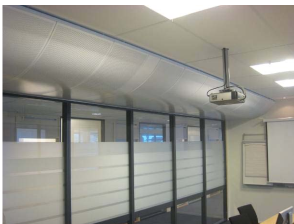
Figur A-10. YIT Klimatak. (Foto: SINTEF Byggforsk/ Jørn Stene)
