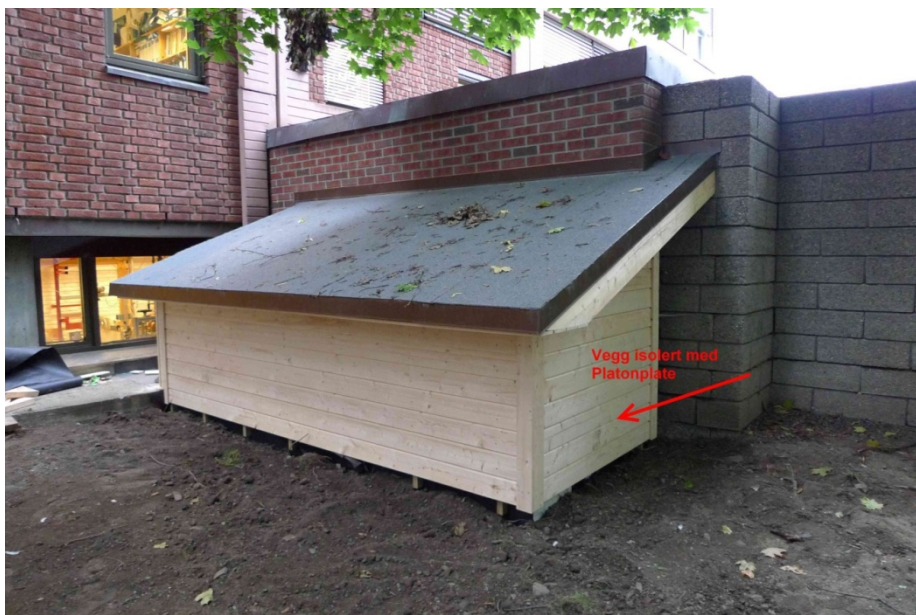
Fig. 3.3.1 Forsøkshus med gavlvegg som under terreng er innvendig isolert med en Platon Multi plate, se figur 3.3.1. 1,2 m av veggen er under terrengoverflate.
