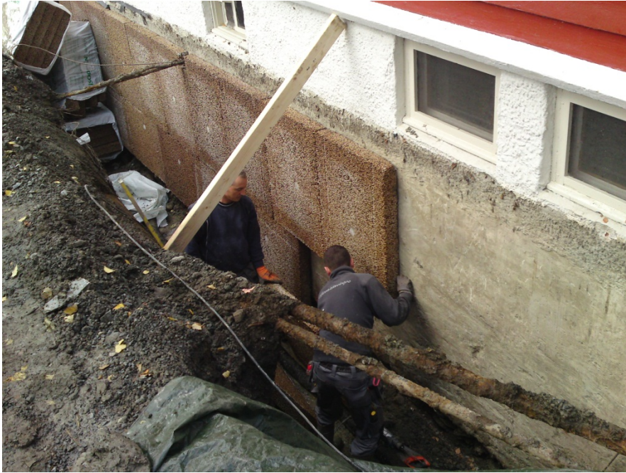
Figur 2.4.2 Montering av Isodren-platen.
