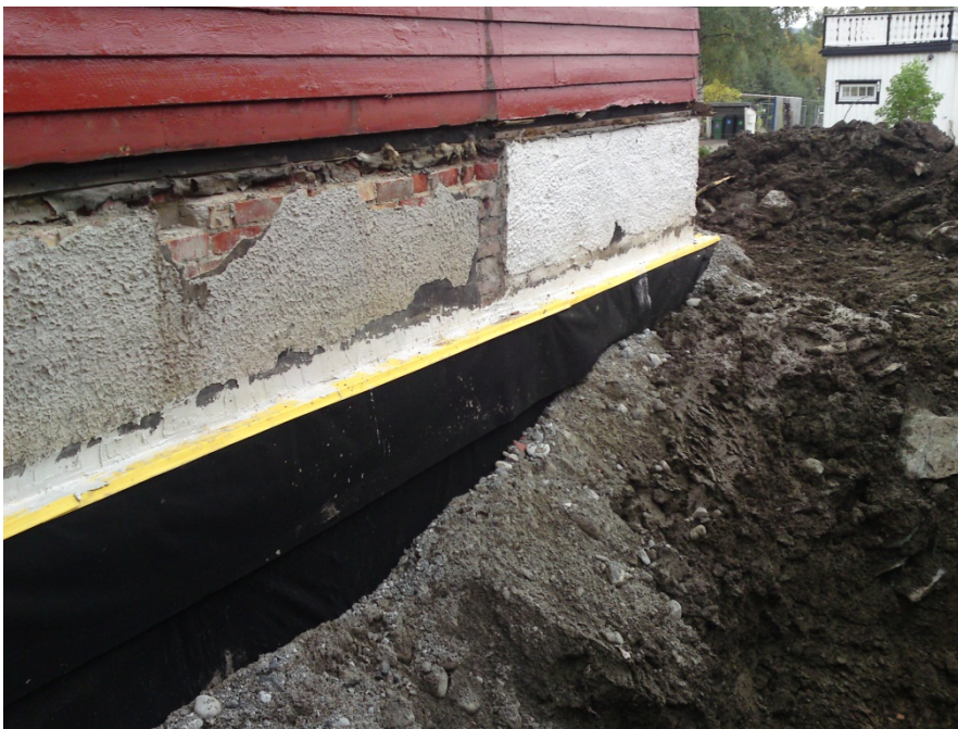
Fig. 2.4.3 Etter montering av utvendig grunnmursplate og innpussing av toppbeslag (gult plastbeslag).
