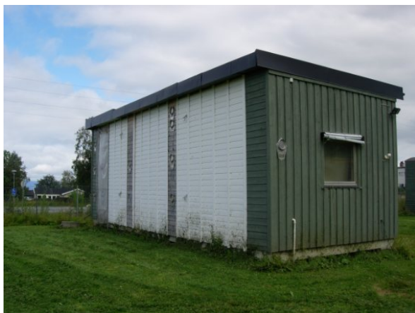
Fig 2.2 Prøvehuset på Voll før ombygging sett fra sydvest
