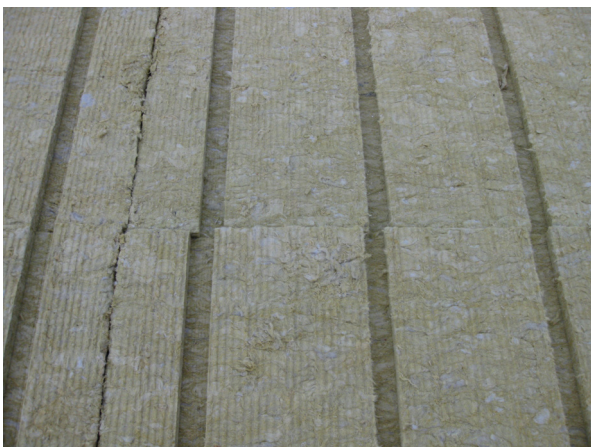
Fig. 2.7 Det var ganske lett å legge ut platene slik at luftkanalene ble gjennomgående uten brudd eller forskyvninger. Likevel ble det noen lokale innsnevringar ved skjøtene mellom isolasjonsplatene som kan begrense luftgjennomstrømningen noe i praksis.
