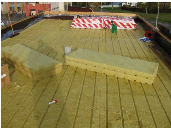
Fig 2.6 Isolasjonslag nr. 2 med kanaler ferdig lagt og klar for tilførsel av vann.
