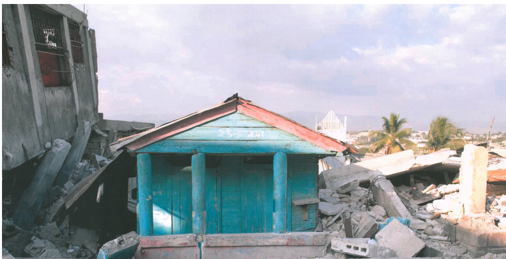
Figur 1.4 Undersøkelser viser at trebygninger ofte er mer robuste og blir påført færre skader ved jordskjelv (bilde fra Haiti etter jordskjelvet 12. januar 2010). Foto: Jörgen Hildebrant [21]
