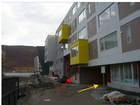
C byggets nordfasade. Innkjøring offentlig P-anlegg markert med gul pil. Trapp til Strandkantens åpne uteområde markert med rød pil.
