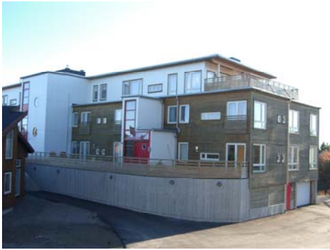
Atkomst siden til lavblokk Bf11. Innkjøring til P-garasje til høyre m/ heis opp til leilighetene.
