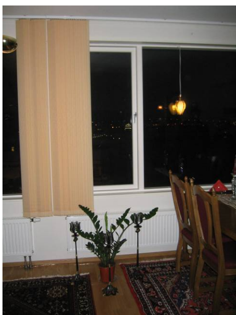
Interiør i C bygget. De første modulbyggene som ble levert fra Kodumaja er med radiatorer i stedet for gulvvarme
