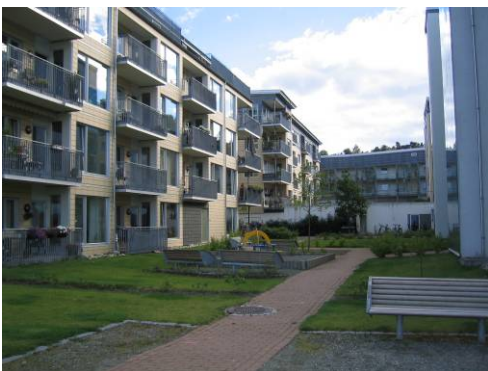
Fasade med balkonger mot gårdsrom i vest
