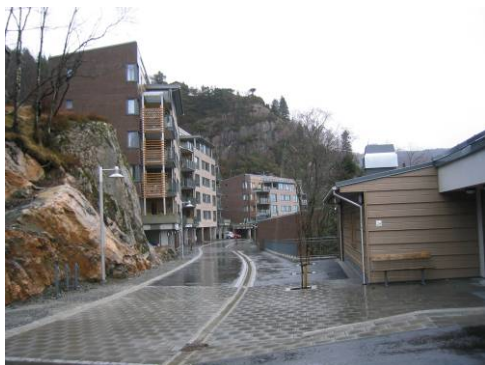
Fra boliggangen mellom hus 1, 2, 3, 4 på nedsiden og hus 5, 6 og 7 på oversiden.
