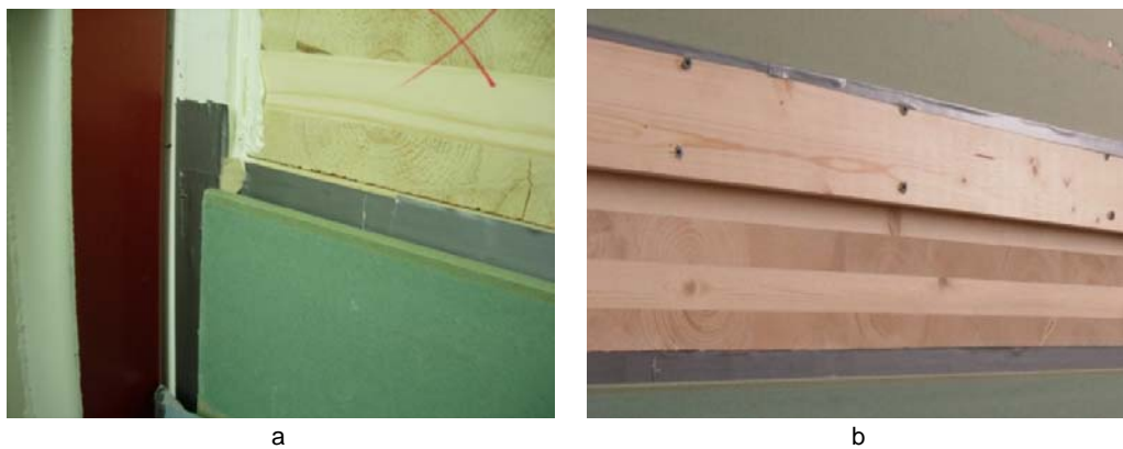
Fig 4.3 Prøvefelt før (a) og etter (b) montering av styrelist og forsegling av veggelementene med plastfolie og gipsplater.
