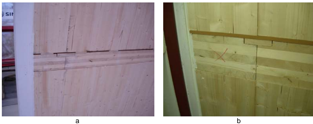
Fig 3.3 Prøvefeltet med massivtre uten kantliming og veggelementer lagt an på klosser av kryssfiner oppå gulvelementer (a). Prøvefeltet med kantlimt massivtre og veggelementer lagt an på sylomérlist (b).
