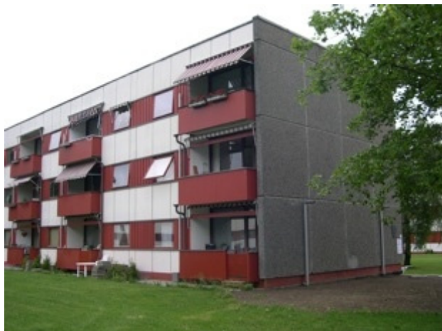
Figur 6.1.1 Viser sydvendt fasade før oppgradering Foto: Arve Brekkhus/Byggeindustrien
