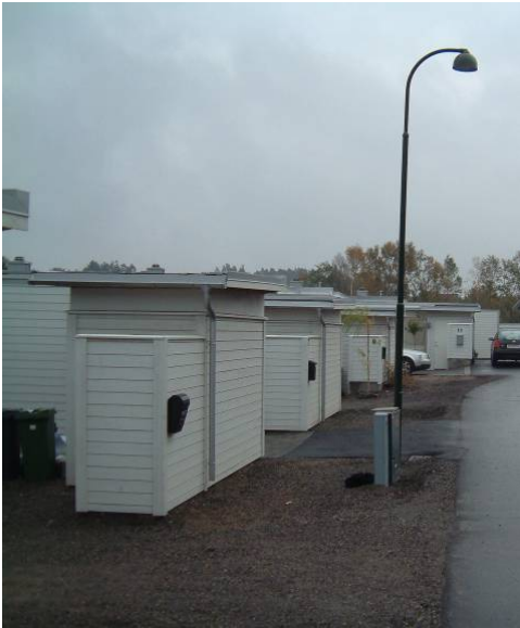
Bodene langs veien
