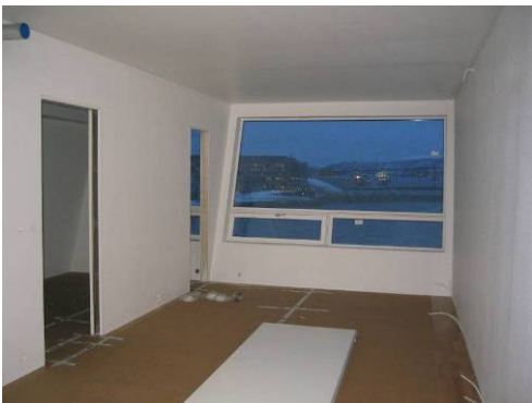
Leilighet i E-bygget under ferdigstilling.
