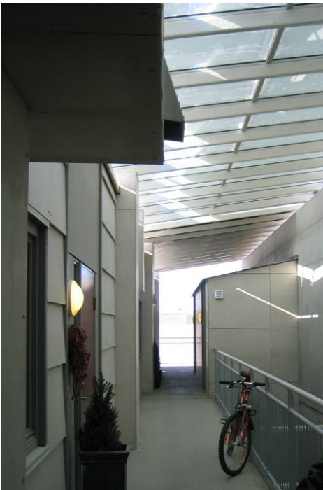
Atkomstsiden med overlys i nedre blokk
