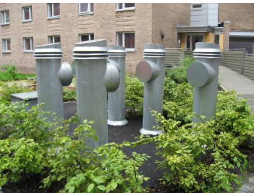
ENVAC søppelhåndteringssystem
