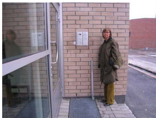
Ringetablået er montert for høyt for barn og rullestolbrukere
