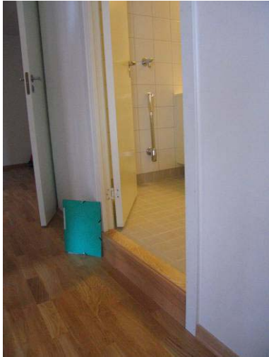
Terskel til bad
