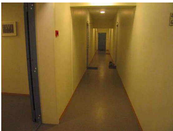
Dårlig belysning i korridor. Dørmatter ol. i gangbanen
