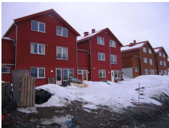
Boliger på nedsiden av vegen, sett fra nord-vest
