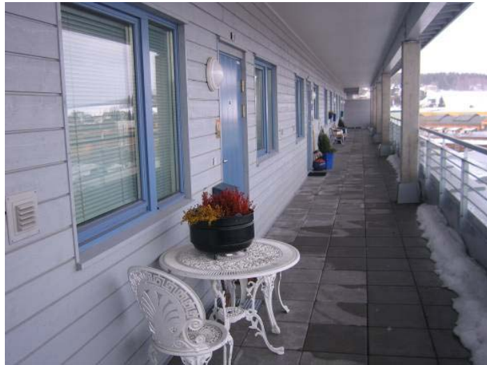
Svalgang på takterasse. Alle vinduer er blendet med persiener eller gardiner
