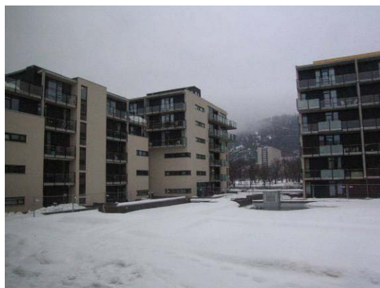
Øvre del av felles uteareal over garasjekjeller
