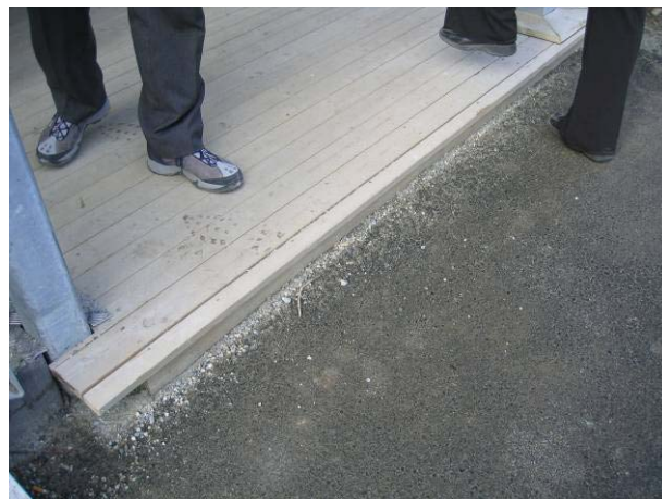
Nivåforskjell mellom svalgang og bakkenivå
