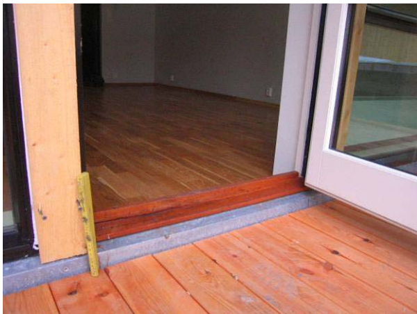
Dør til uteplass/balkong: 60 mm innside, 100 mm utside
