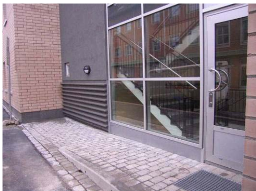
Rampe ved inngangsdør. Ingen markering av nivåforskjell
