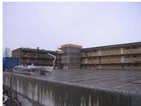
Parkeringshus, blokk 3 og 4 med heisen mellom dem
