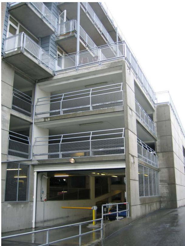
Innkjøring til parkeringshus i 3 etasjer
