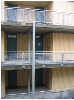
Nybygde, inngang via svalgang
