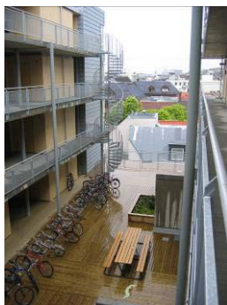
Gårdsrom i nybyggdel
