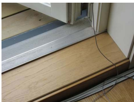
Terskel til balkong
