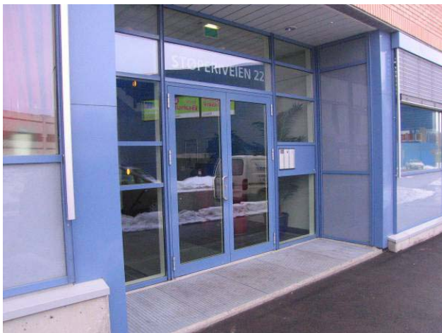
Inngangsparti mot torget. Glassfeltene i dørene er ikke merket.
