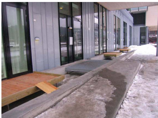
Inngang fra elvesiden, med rampe 1:14 (under bygging)
