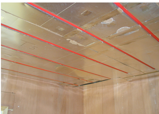
Figur 3.5 b: Takvarme med sentralt plassert tallerkenventil for tilluft. Det er brukt enkelt S-leggemønster for gulv- og takvarmesløyvene og 13 mm gipsplater under 0,5 mm tykke aluminiums varmefordelingsplater.
