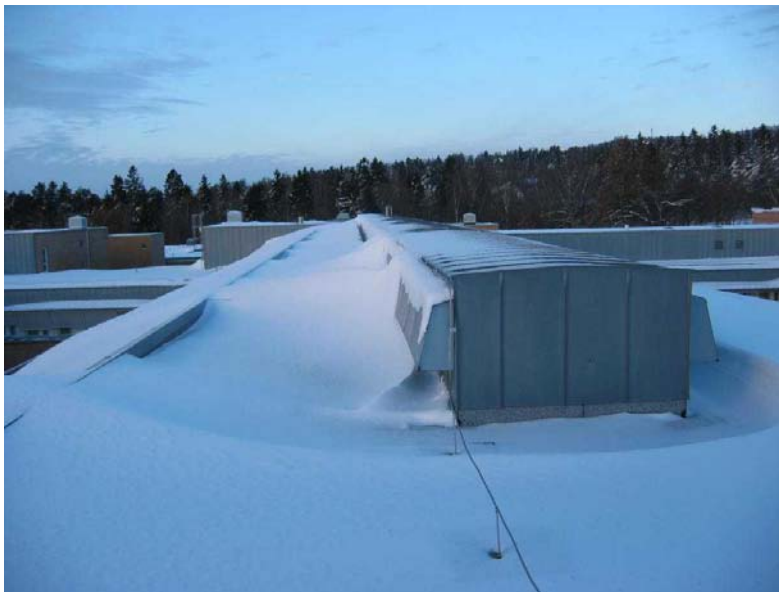
Figur 3.3.4 Ventilasjonsinntak på toppen av en seksetasjes bygning i Oslo. Foto: Rikshospitalet
