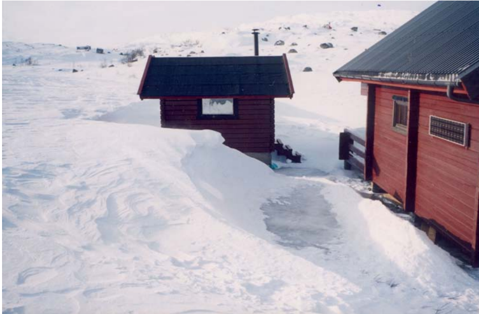
Figur 3.2.2.1 Lofonn som omkranser to bygninger i høyfjellet (Bjørnfjell, Nordland). Foto: Byggforsk
