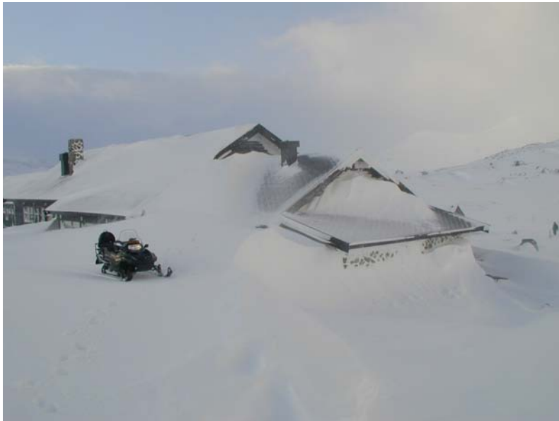
Figur 3.2.2.6 Tak med nivåforskjell på Finse. Foto: Byggforsk
