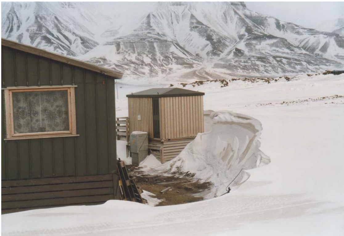
Figur 4.2.1.5 Lofonnen til venstre i bildet skaper et åpent rom mellom snø og værvegg. Hovedvindretning fra høyre. Foto: Anker Nielsen
