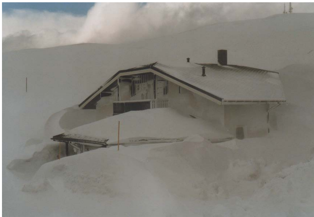
Figur 4.2.1.2 Bygninger som er plassert bak en rygg står ofte i fare for å bli begravd i snø (Hammerfest). Foto: Anker Nielsen
