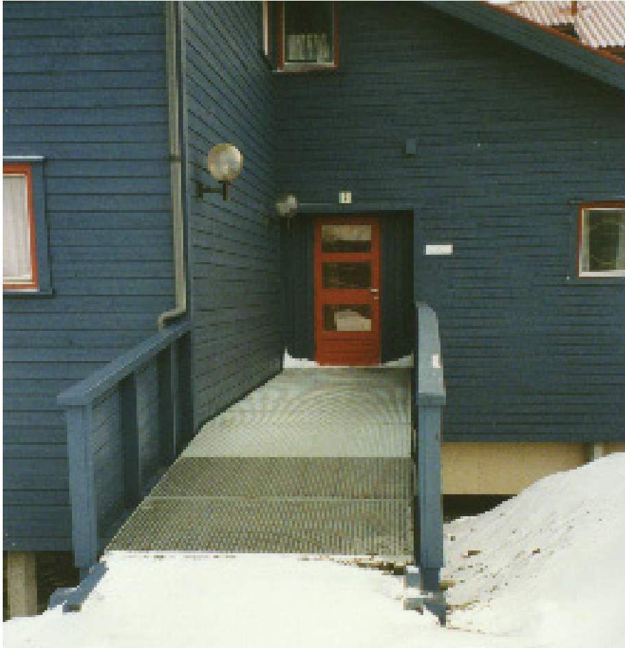
Figur 4.3.1.4 Rampe til inngangsparti til bygning på Svalbard. Foto: Byggforsk
