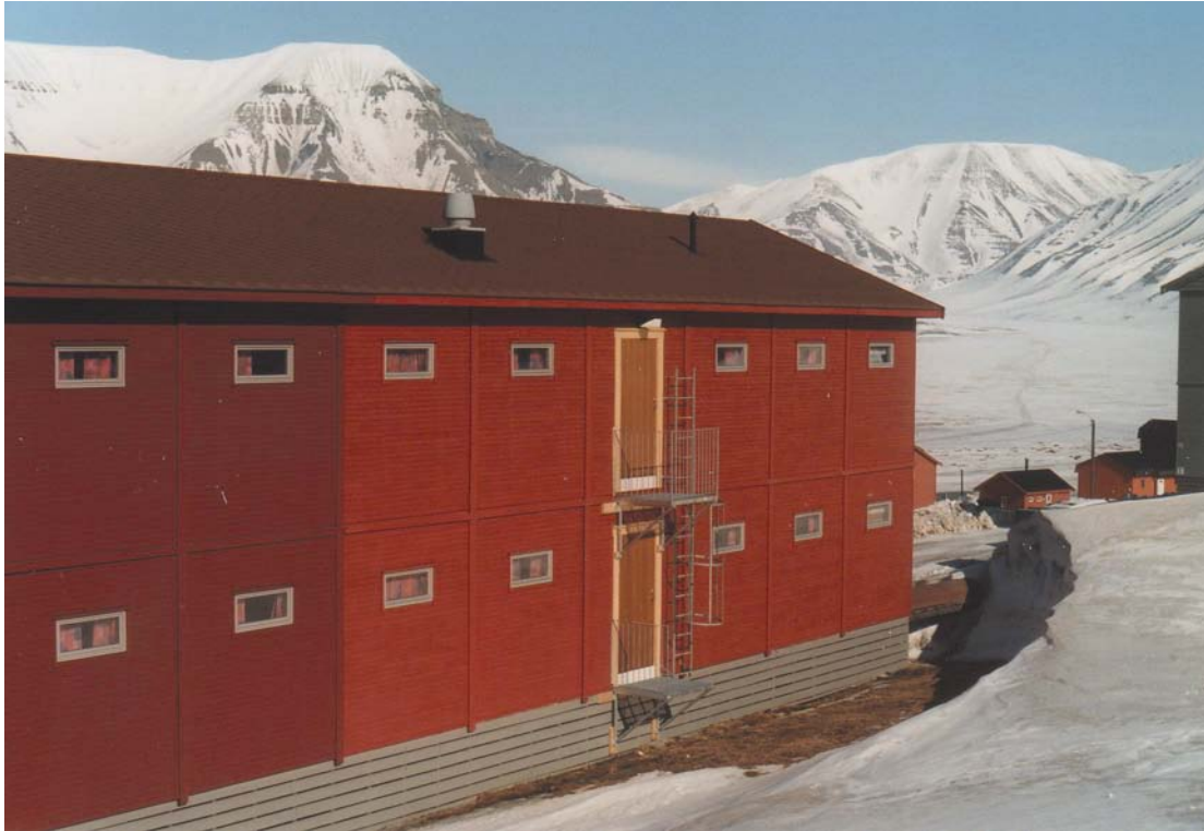
Figur 4.2.1.4 Lofonn markerer utstrekning av hesteskovirvel som fører til en åpen sone mellom værvegg og snøfonn. Hovedvindretning fra høyre. Foto: Anker Nielsen
