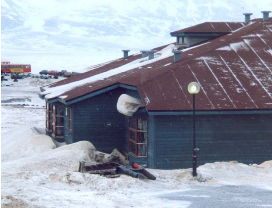
Figur 3.3.1 Karnapp med snøfonn. Framherskende vindretning fra høyre (Longyearbyen). Foto: Byggforsk
