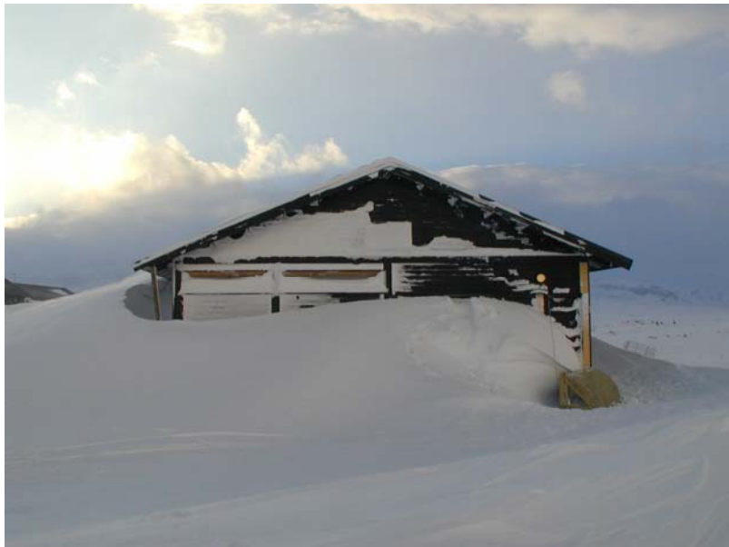
Figur 3.2.2.5 Lesonefenn på Finse forskningsstasjon. Foto: Byggforsk
