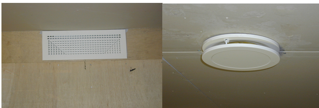
Figur 3.10: Tilluftsventil type TLK-2k (t.v.) og TLG (t.h)
