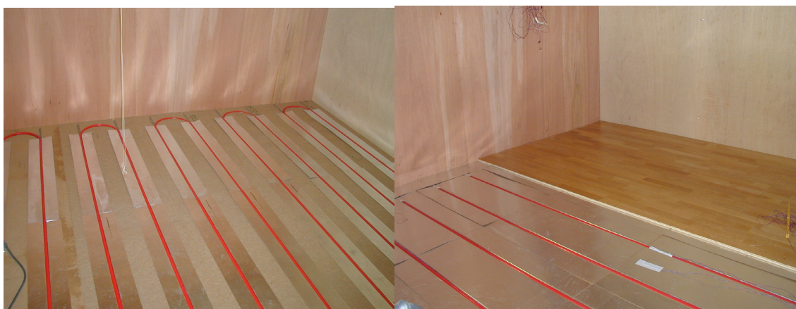
Figur 3.6: Varmefordelingsplater gulv før (t.v) og etter (t.h) ombygging
