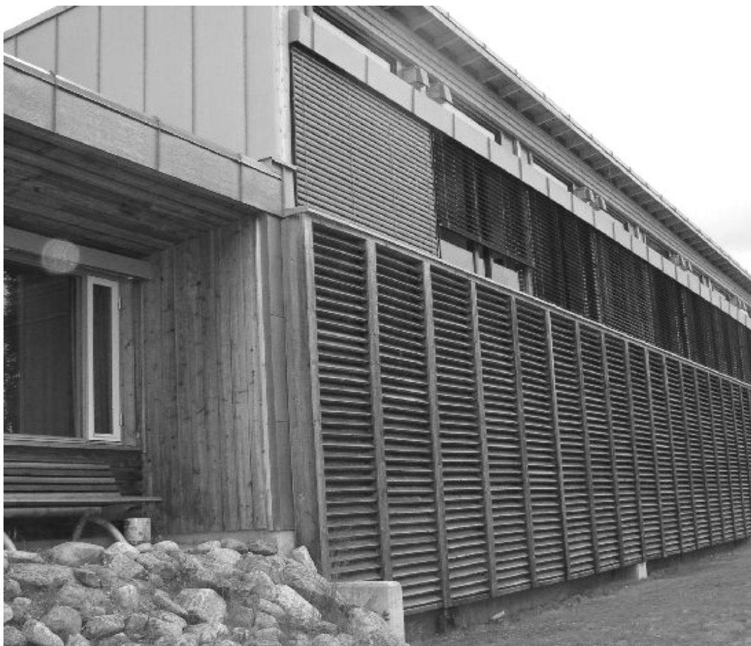
Figur 2.8 Dette bildet er av Forvaltningsbygget. Her ser vi Vestlandskledning brukt som sjalusi. (foto: NBI).
