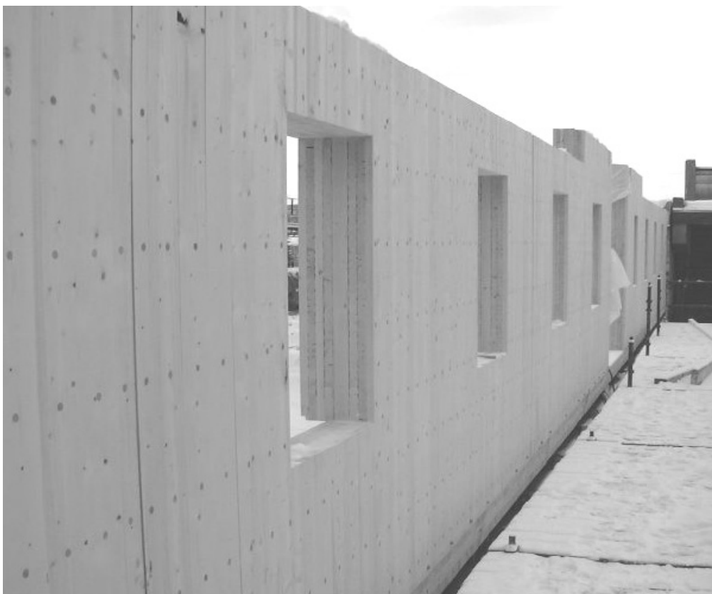
Figur 2.1 Forvaltningsbygget under oppføring (foto: Silvinova AS).
