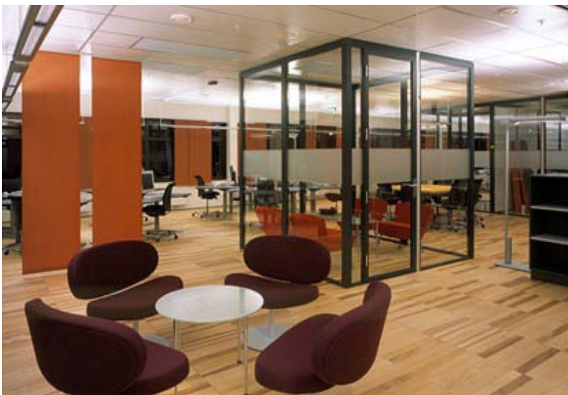
Figur 15 Eksempel heldekkende flat og lydtett himling. Telenors nye hovedkvarter på Fornebu.
