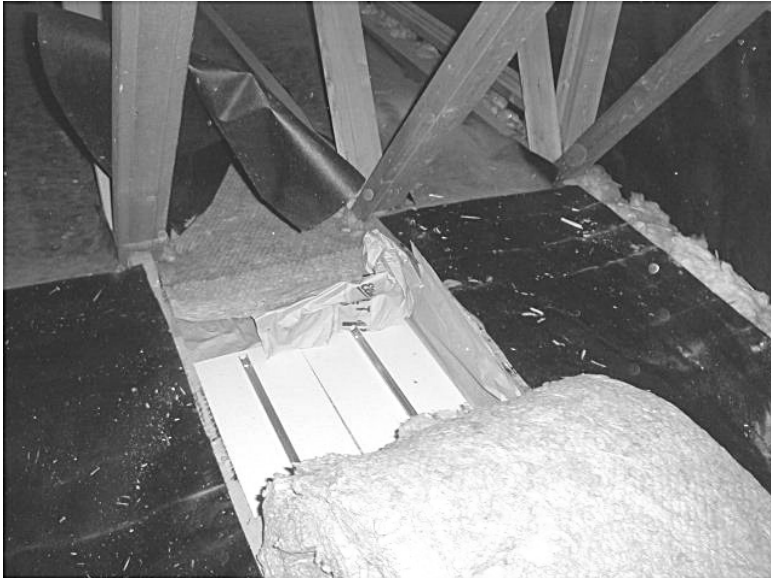
Fig. 3.13. Det er plass til to varmefordelingsplater som skrus fast til den eksisterende himlingen og fyller hele mellomrommet mellom takbjelkene. Isolasjonstykkelsen økes fra 150 til 300 mm.
