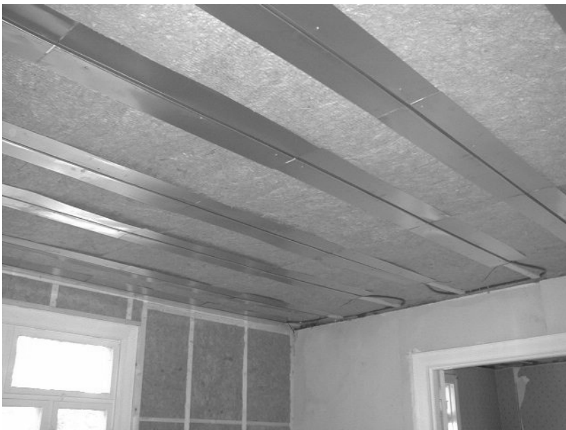
Fig. 3.9. Lydhimling med varmfordelingsplater, varmerør og dempningsisolasjon. Gipsplater festes deretter til sekundærlektene med skruer.
