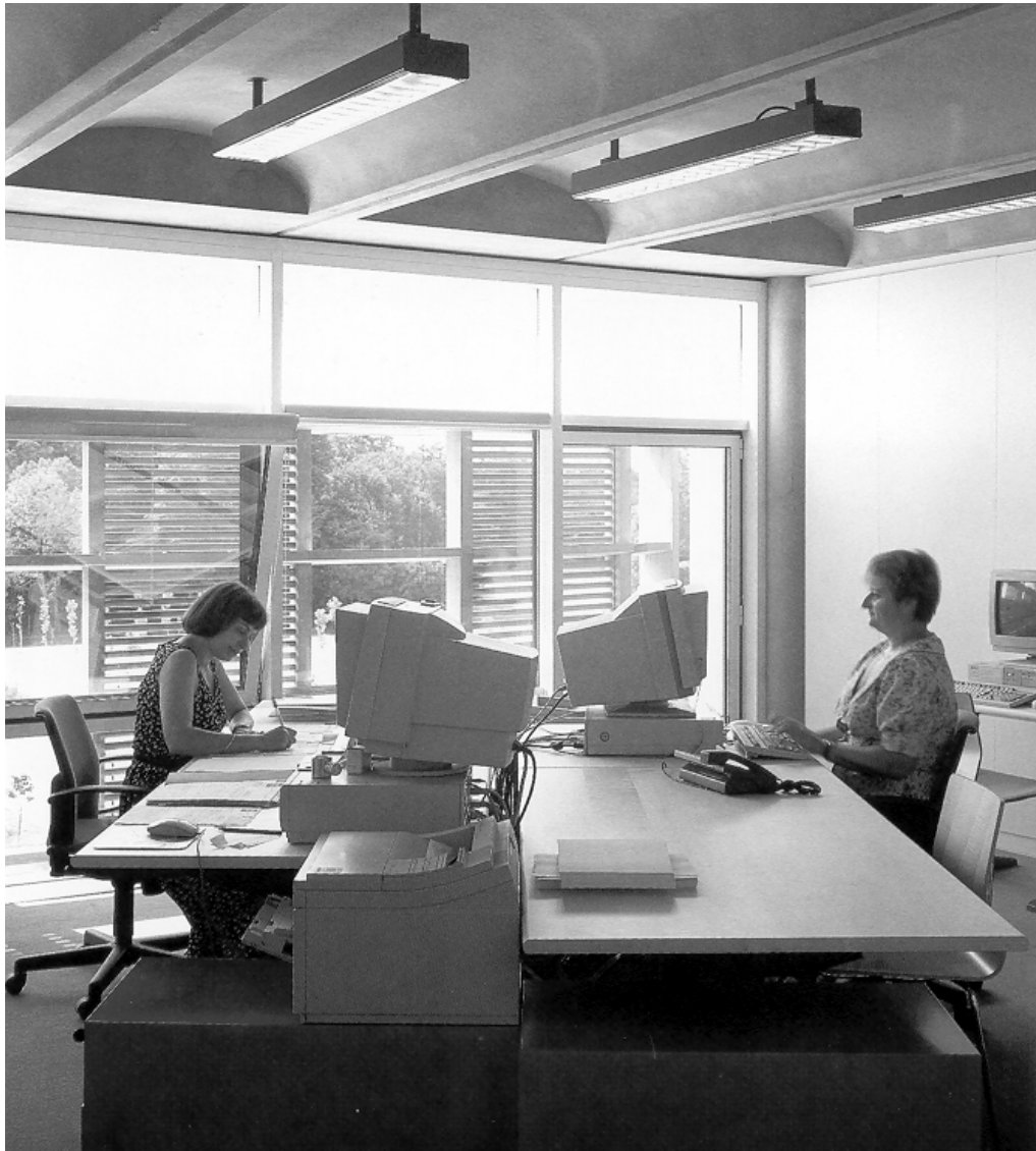
Fig 4.3-1: Eksempel på kontorbygg uten himling i sonen nærmest yttervegg. Noen av fordelene med å eksponere betongen er bl.a. bedre temperaturutjevning, større takhøyde og bedre lydisolasjon over skillevegger.
