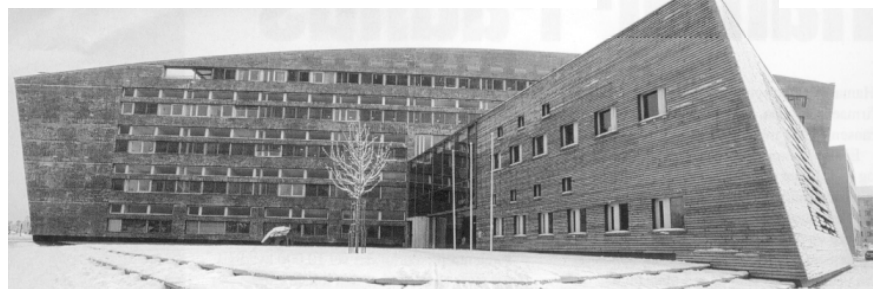
Fig. 2.3b-3 (t.v.): En kombinasjon av høysittende vinduer og vinduer i vanlig høyde gir både god belysning og godt utsyn
