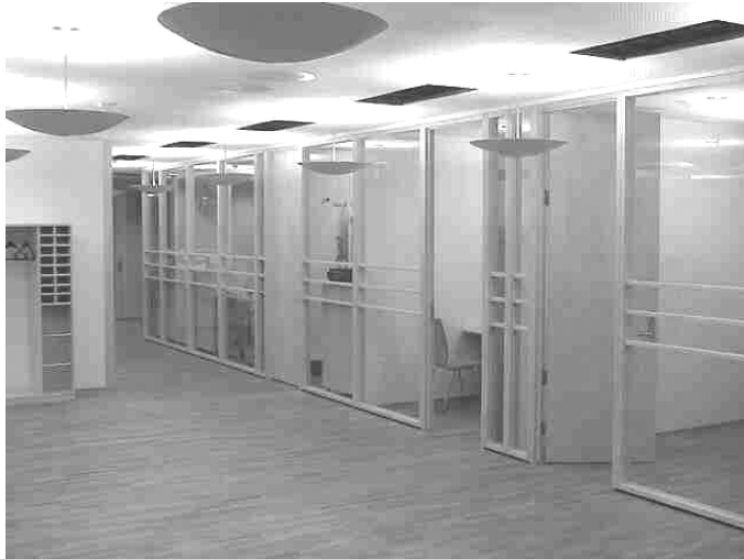
Figur 4.3-5: Himling med demonterbare plater kun i korridorsonen. (Telenors kontorbygg i Bergen, Ark: Pedersen/Ege og Bjerk & Bjørge)
