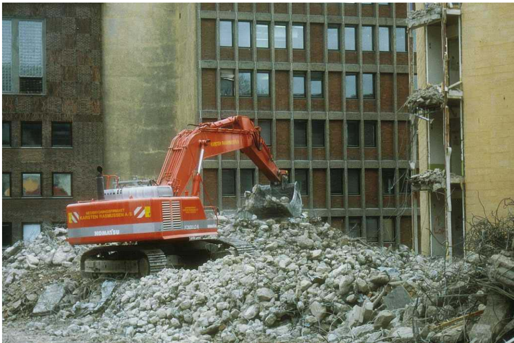
Figur 5: Etter riving ble større betongbiter klippet fra armeringen maskinelt. Deretter ble massene grovsortert. Til høyre står deler av tilbygget til barneklubben, oppført i 1989.
