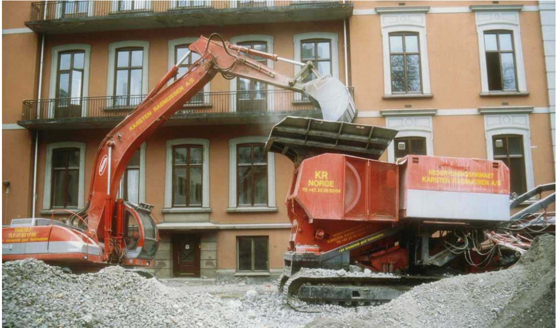
Figur 9 Gjenvinning ble gjennomført med et mobilt knuseverk, levert av det danske entreprenørfirmaet Karsten Rasmussen AS. Etter to omganger med knusing var det ferdige produktet tegl eller betong i fraksjonene 0-45 mm, 45-80 mm og 0-80 mm.
