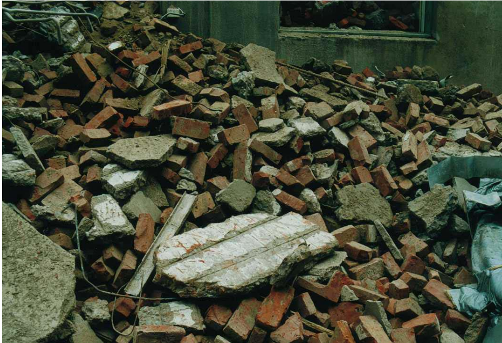
Figur 9 Sortert tegl for transport til gjenvinningsanlegg.
