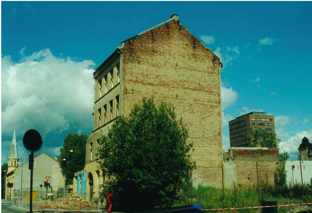
Figur 1 Bygård oppført i tegl i 1862. Bygget ble tømt for løsøre, og miljøsanering gjennomført før maskinell riving av bærende konstruksjoner startet.
