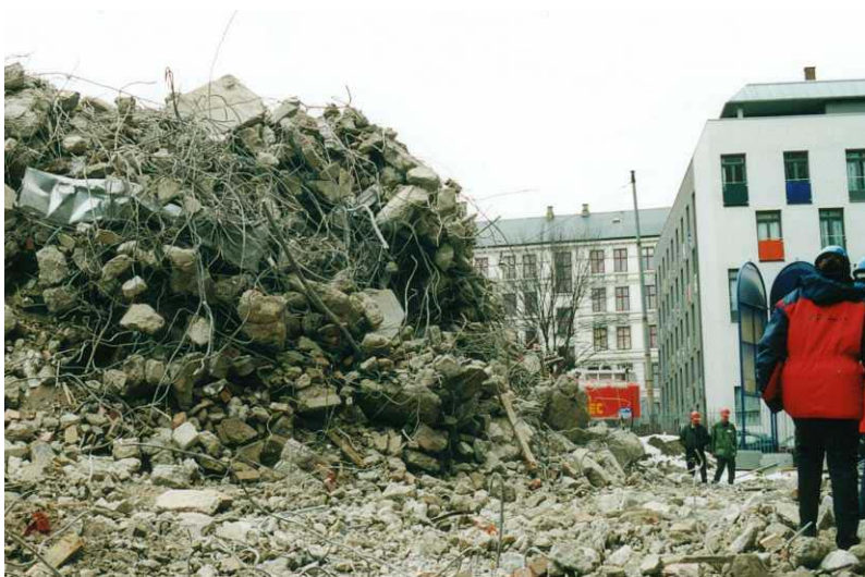
Figur 6 De grovsorterte massene ble bearbeidet for å få skille ut mest mulig armering fra betongen før gjenvinning i knuseanlegg.
