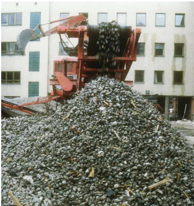
Figur 10 Betong etter første gangs knusing. Armeringsjern ble fjernet med magnetbånd mellom knuseenheten og transportbåndet.
