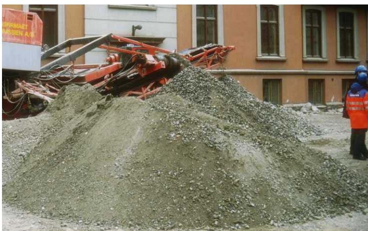
Figur 12 Fraksjonen 0-45 mm etter andre gangs knusing.
