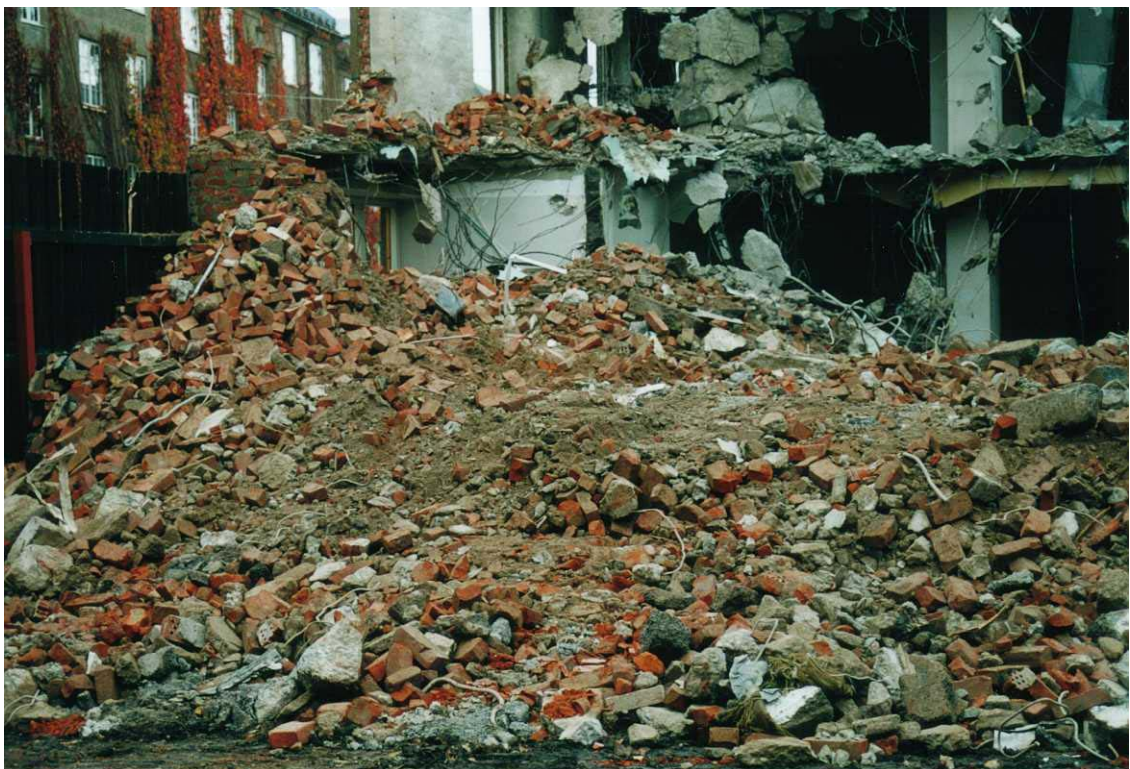
Figur 8 Tegl ble i riveperioden benyttet til oppfylling av kjelleren slik at anleggsmaskinene kunne bevege seg inntil bygget under riving.
