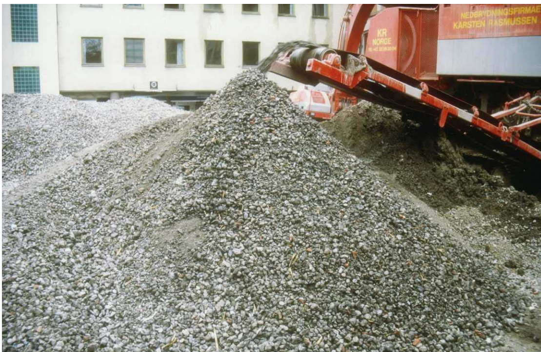
Figur 11 Fraksjonen 45-80 mm etter andre gangs knusing.
