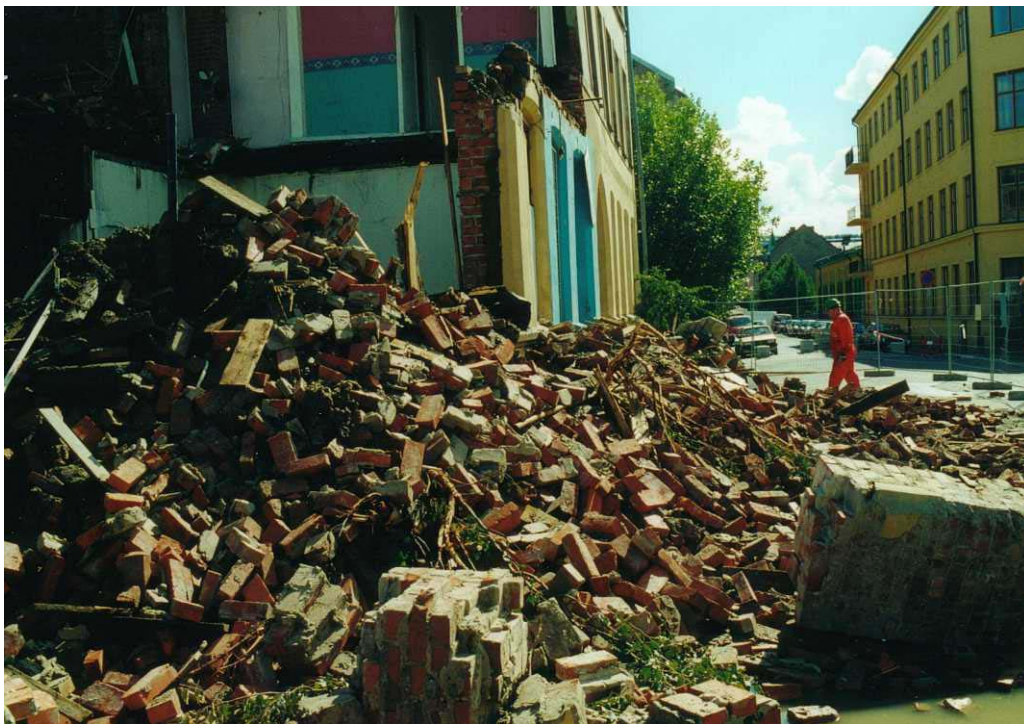
Figur 4 Trevirke ble sortert ut både maskinelt og manuelt før levering av tegl til materialgjenvinning.
