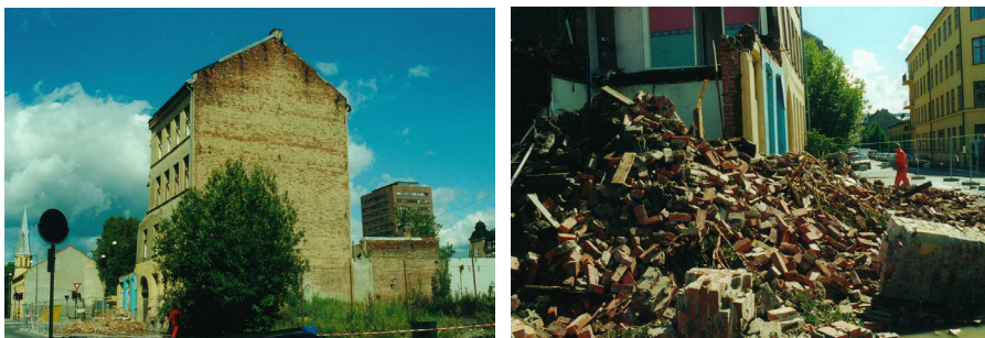
Figur 9 Riving av bygård oppført i tegl.
