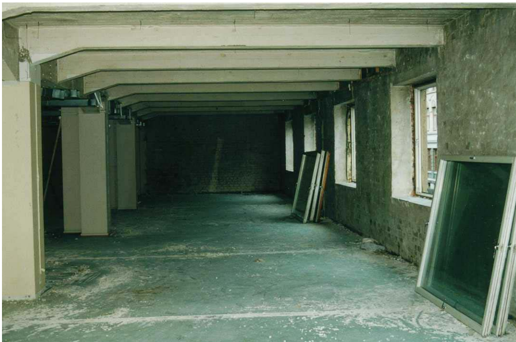
Figur 2 Råbygget inneholdt til slutt bare enkelte deler av ventilasjonssystemet, noe trevirke, og gulvbelegg i enkelte etasjer.
