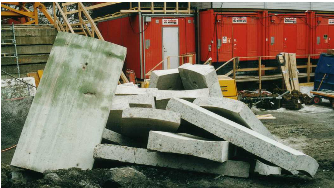
Figur 4 Betongblokkene ble samlet på bakkenivå for transport til gjenvinningsanlegg.
