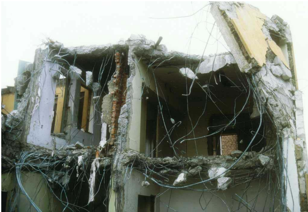
Figur 4: Nærbilde av konstruksjonen under riving. Strukturen består som vist av både armert betong og teglkonstruksjoner.
