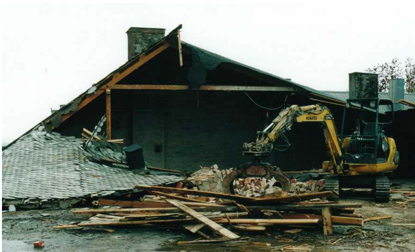
Figur 3 Ved oppstart av riving på taket. Takstein ble sortert separat, mens trevirke, metaller og tegl ble tippet på bestemte sider av bygget for sortering i containere på bakkenivå. Forurenset tegl fra pipeløp ble sortert separat og levert til deponi.
