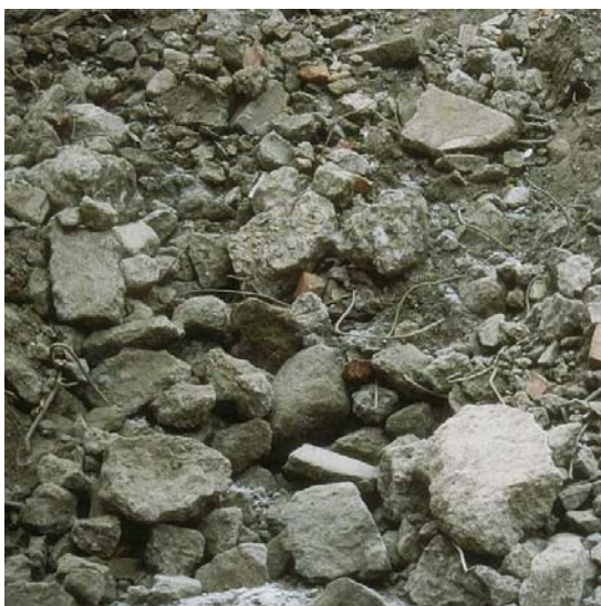
Figur 8 Etter grovsortering er betong med små mengder gjenværende armering klar for gjenvinning.
