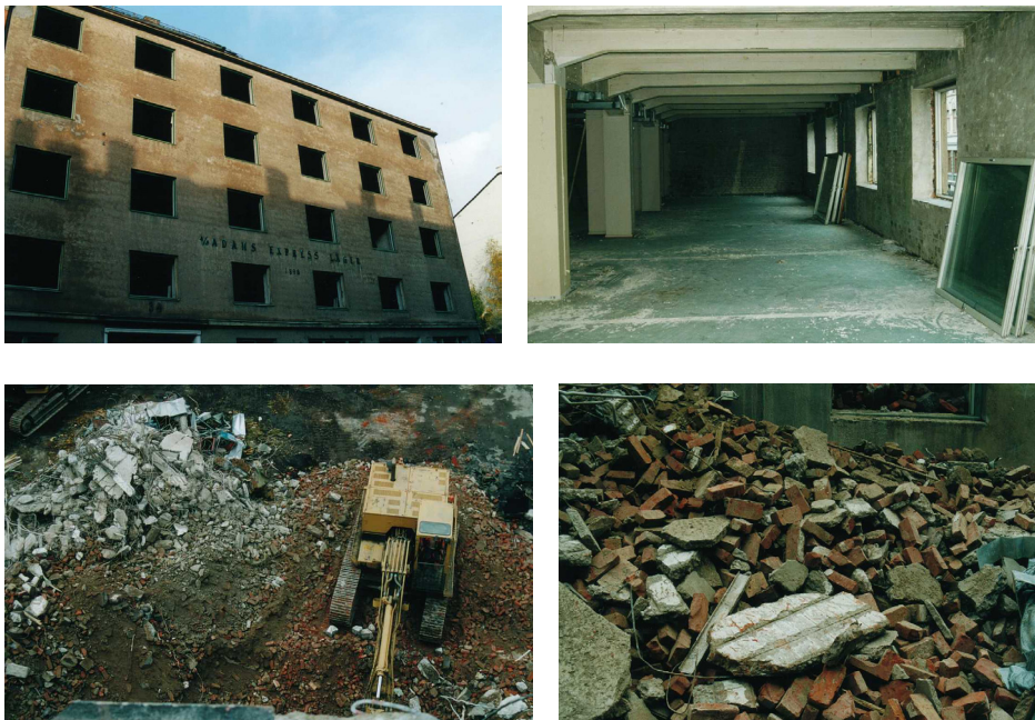
Figur 8 Riving av kontorbygg oppført i plasstøpt betong med teglfasader.
