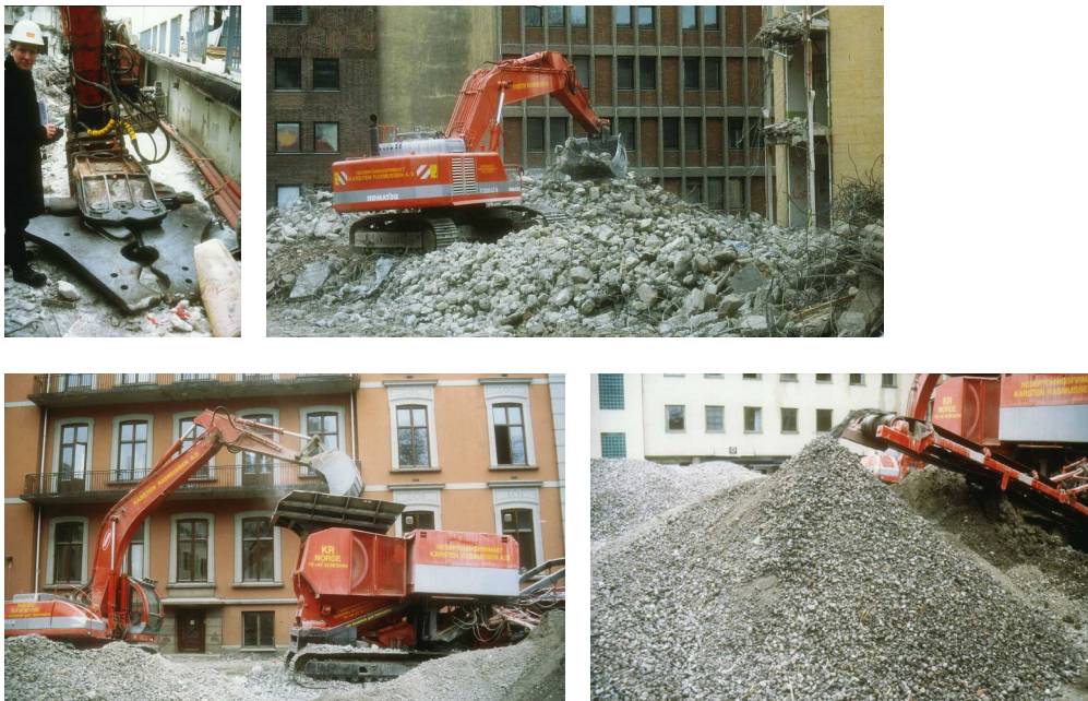
Figur 6 Riving og håndtering av betong og tegl ved Pilestredet Park.
