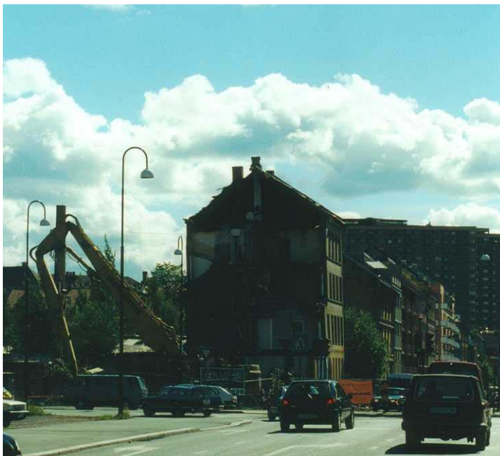
Figur 2 Et inntrykk av dimensjonen på anleggsmaskinen som ble benyttet ved riving.
