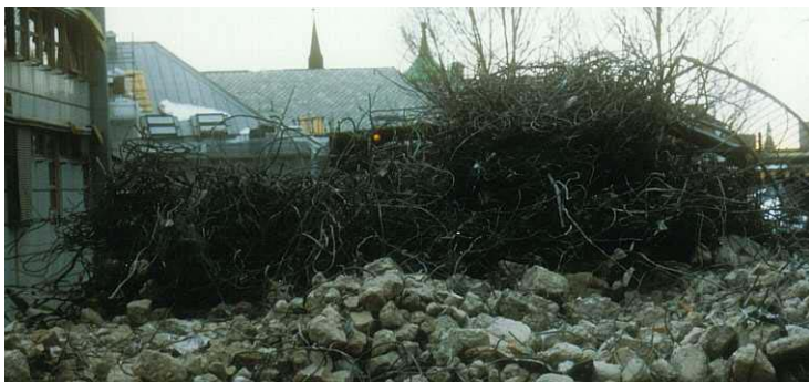
Figur 7 Armeringsjern ble sortert separat for levering til metallgjenvinning.
