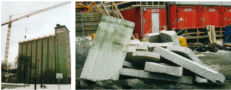
Figur 7 Utskjæring av betongblokker fra vegger av kornsilo i Marselis gate.
