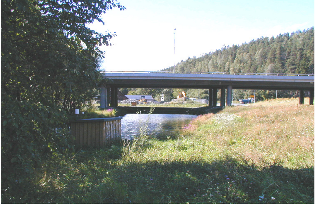
Figur 3 Deler av Skullerudkrysset i Oslo, fotografert fra utvalgt prøvetakningsområdet. I forgrunnen vises et sedimenteringsbasseng, som skal rense overflatevannet fra veibanen.
