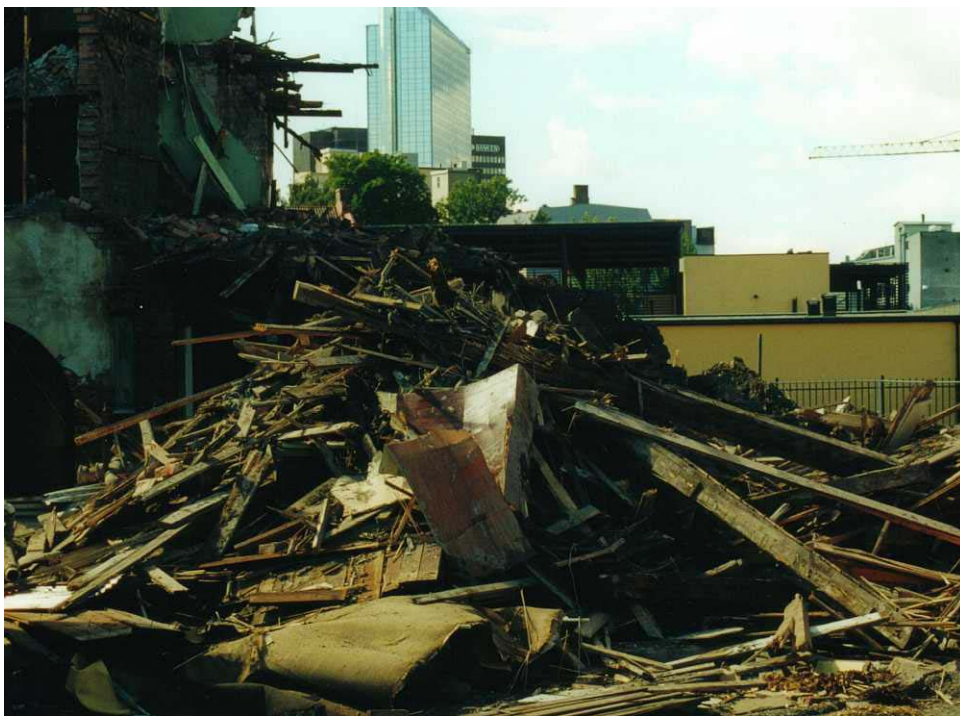
Figur 6 Trevirke etter maskinell grovsortering.
