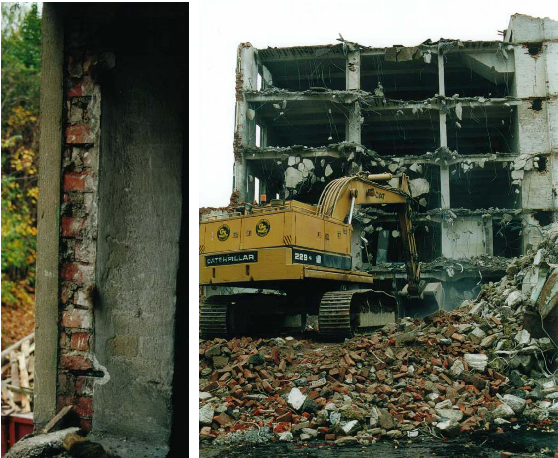
Figur 5 Bærende strukturer bestod av plasstøpt betong, med teglfasade. Bygningen ble revet med samme type anleggsmaskin som ved Pilestredet Park.
