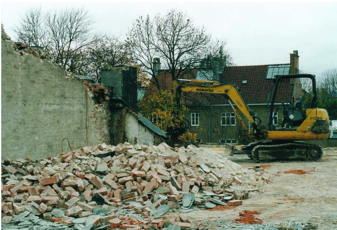
Figur 4 Teglstrukturen i pipeløpet nærmest tilstøtende bebyggelse var svært løs og porøs. Den ble fjernet med stor forsiktighet for å unngå at deler skulle falle ned i bakgården.
