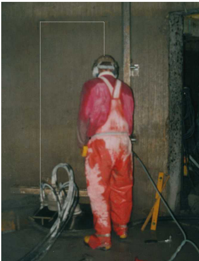
Figur 3 Utskjæring av betongblokker fra vinduer og dører ble utført med spesialutstyr styrt av en operatør. Det stiplede omrisset viser størrelsen på blokken som skal skjæres ut.
