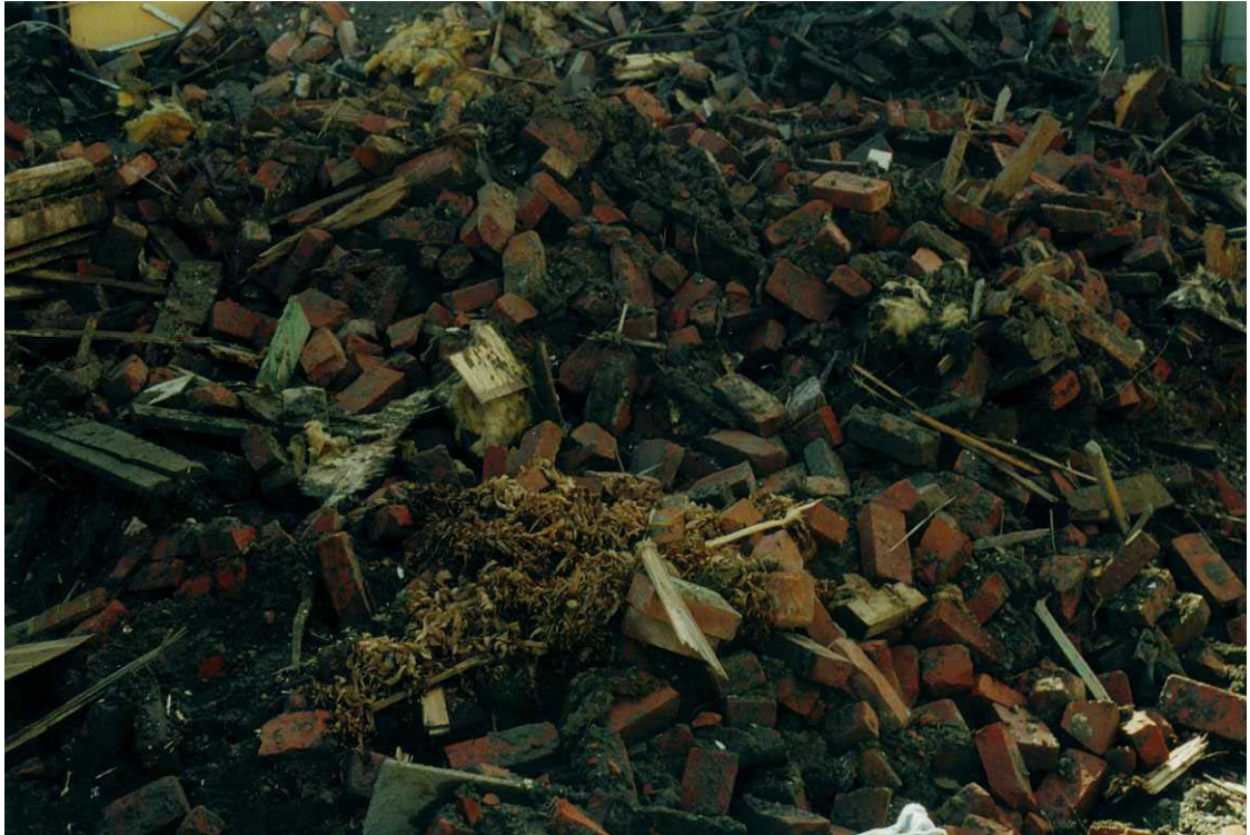
Figur 5 Nærbilde av rivemasser før grovsortering.
