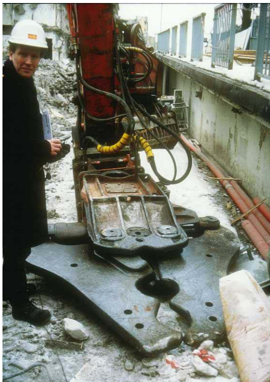
Figur 3: Bygget ble revet maskinelt med utstyr fra det svenske firmaet Demotec. Saksen på anleggmaskinen som klippet ned konstruksjonene var som vist av kraftig dimensjon.
