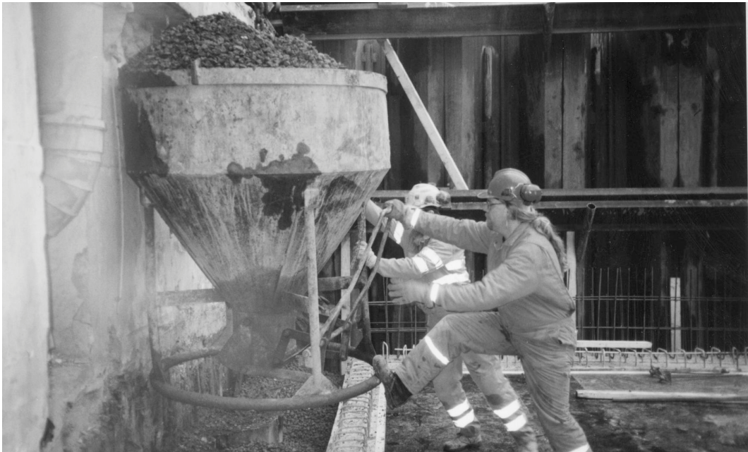
Figur 10. Tilbakefylling av resirkulert tilslag mot spunt i Inkognitogaten i Oslo
