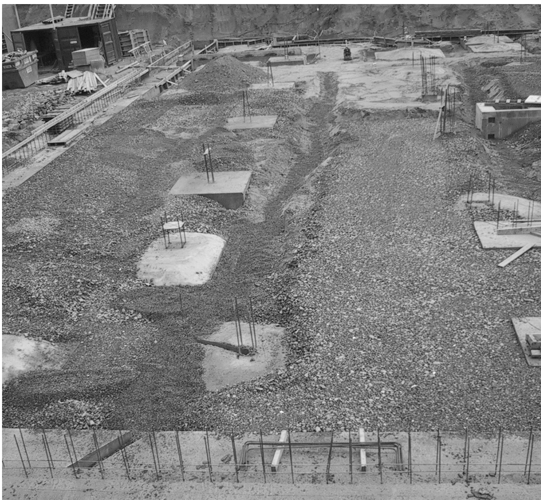
Figur 11. Bruk av resirkulert tilslag som kapillærbrytende sjikt under gulv
