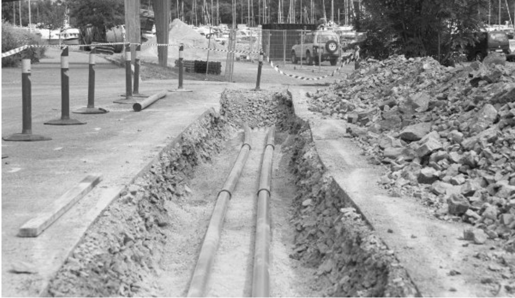
Figur 9. Kabelgrøft Frognerkilen i Oslo
