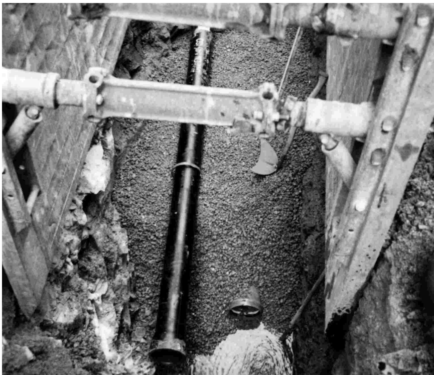
Figur 8. Utlegging av resirkulert tilslag i VA-grøft i Dalsnaret
