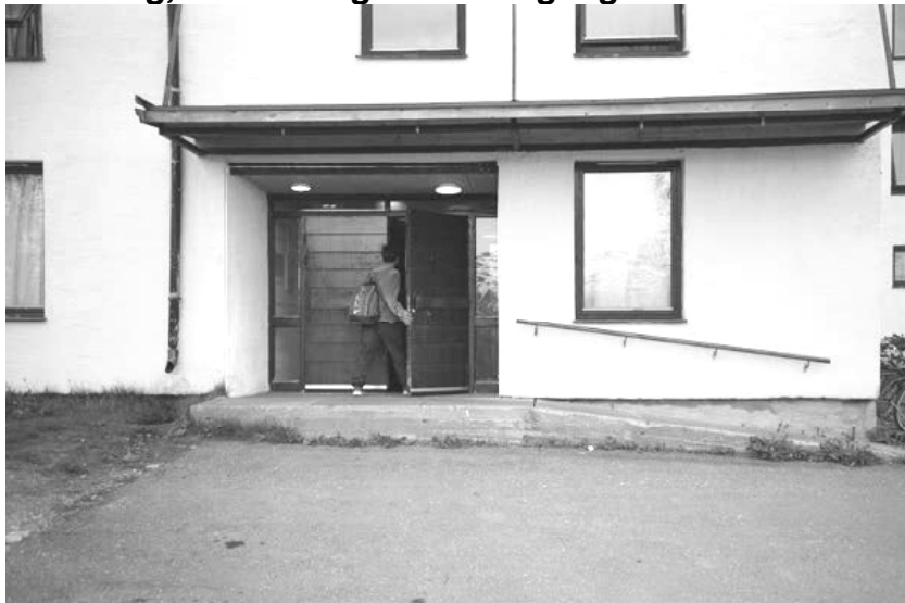
Parkeringsplass umiddelbart foran inngangsdøra. Rampen har rekkverk bare på en side.
