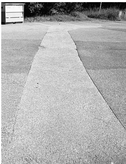
Utbedring av asfalt har gitt en godt synlig stripe – visuelt kan den fungere nesten som en ledelinje.
