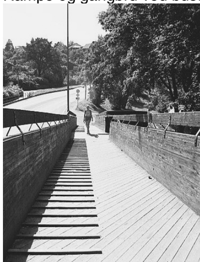
Rampe og gangbru ved bussholdeplassen
