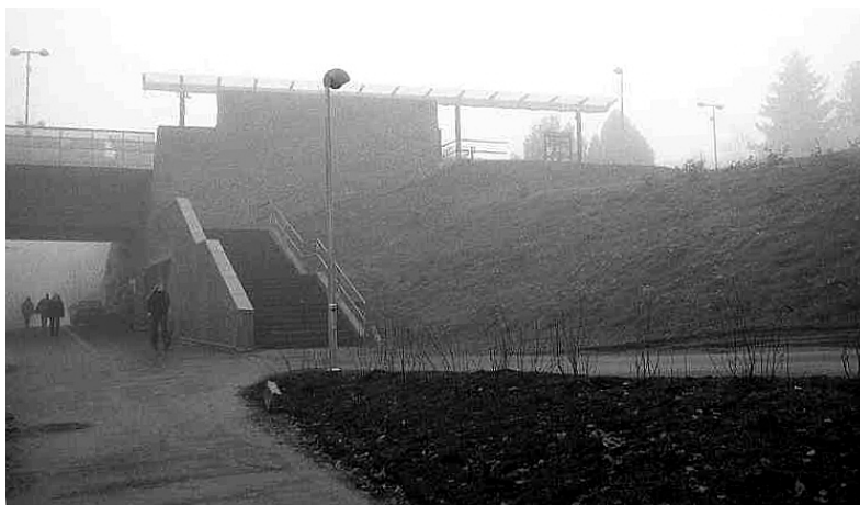
Atkomst til Forskningsparken stasjon, retning mot sentrum: lang trapp eller en enda lenger, skrånende gangvei (mot høyre på bildet).
