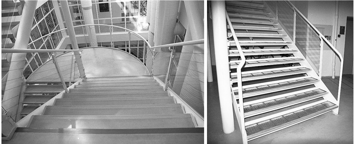
Hovedtrapp i SV-bygget
