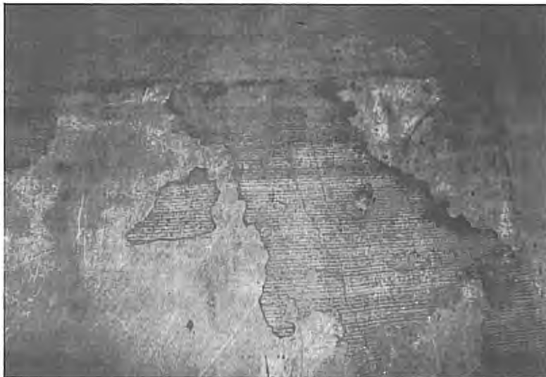
Fig. 4.231 Fotoet viser avskalling av herdeplastbelegg i en sterkt trafikkert sone.
