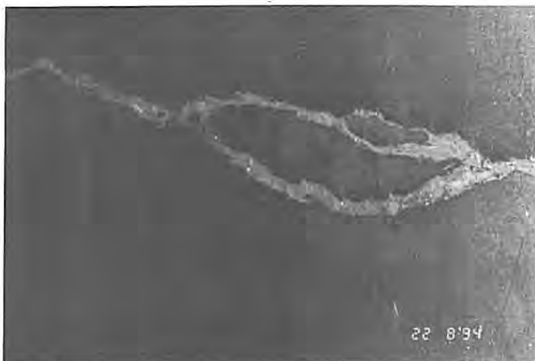
Fig. 4.13 Fotoet viser knusning av sprekkanter.
