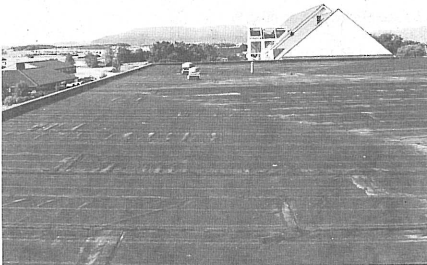
Foto 5 Valker i APP takbelegg. Uoppvirket rull rullet ut i kaldt vær.
