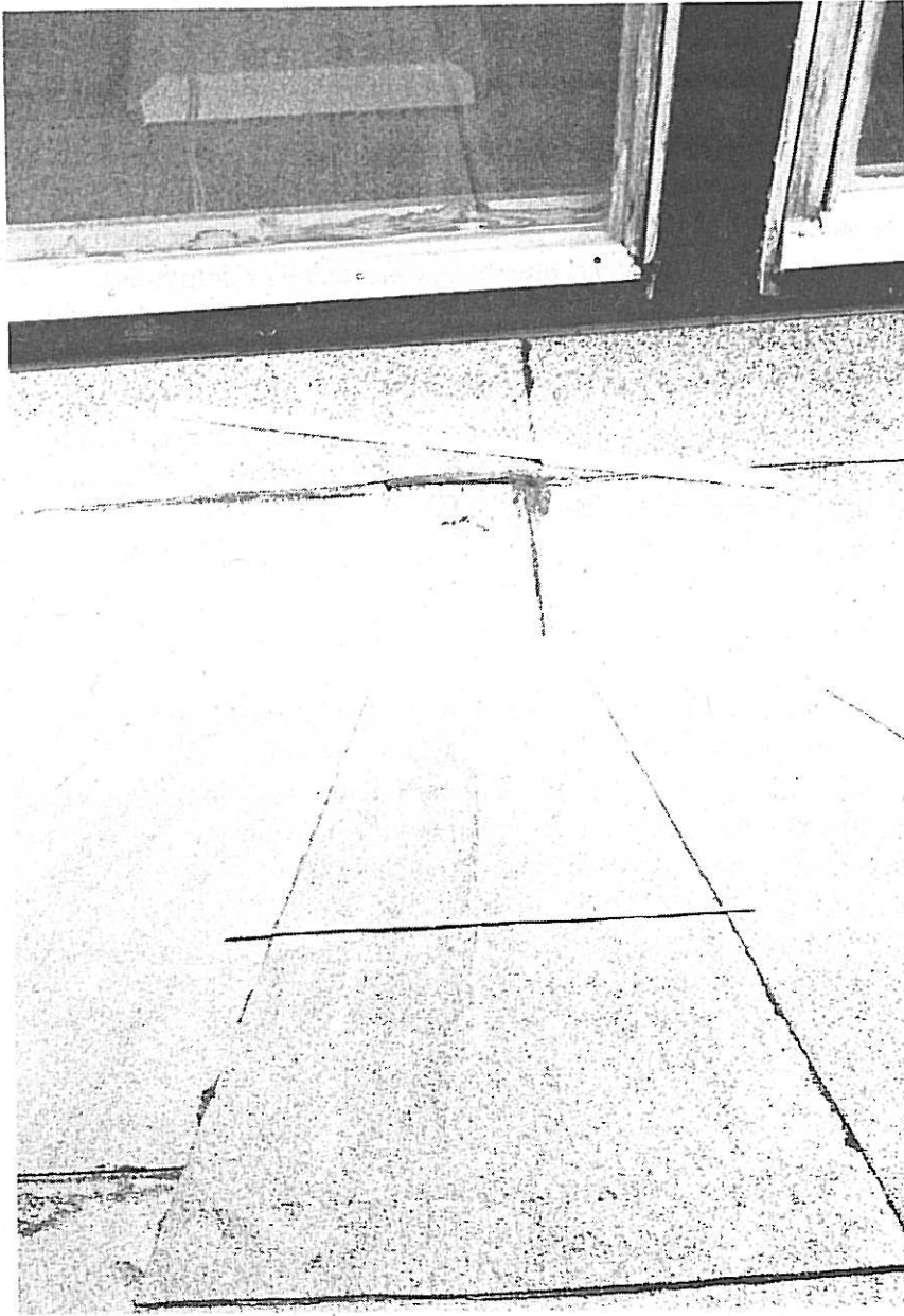
Foto 13 For lav oppkant mellom tekning og vindu.
