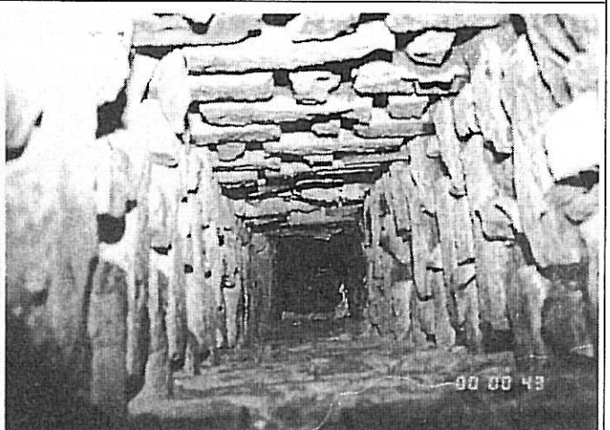
3.6 Gammel pipe sett nedover fra topp.
