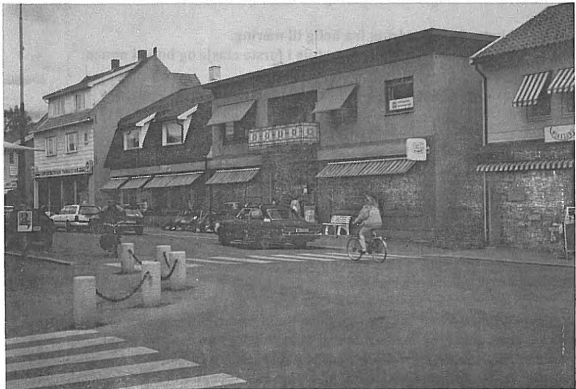
Ettersom forretningsvirksomheten har utvidet vindusarealet i første etasje, har husene fått et sterkt horisontalt preg. Denne todelingen svekker husets egenkarakter og gir et kjedeligere gatebilde.
