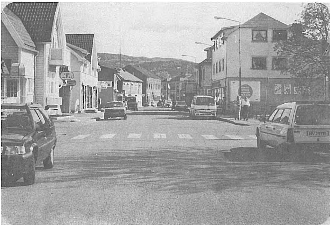
Den lave gesimshøyden gir et solfylt og vennlig gaterom. En kort fasadelengde langs gata og utstikkende arker gir variasjon og rytme i gatebildet.
