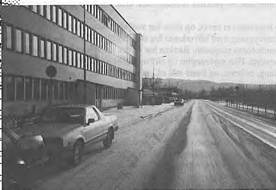
Rådhusgata oppfordrer gjennom sin utforming til stor hastighet. Trær foran vestfasaden på Rådhuset kan dempe den harde virkningen av en så stor flate.
