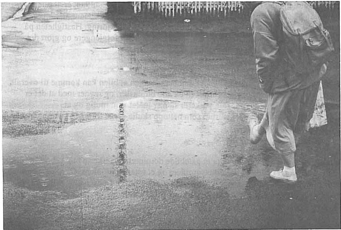
Asfalten blir full av damper ved regnvær og snøsmelting. Meningsløst ubehagelig å være fotgjenger.
