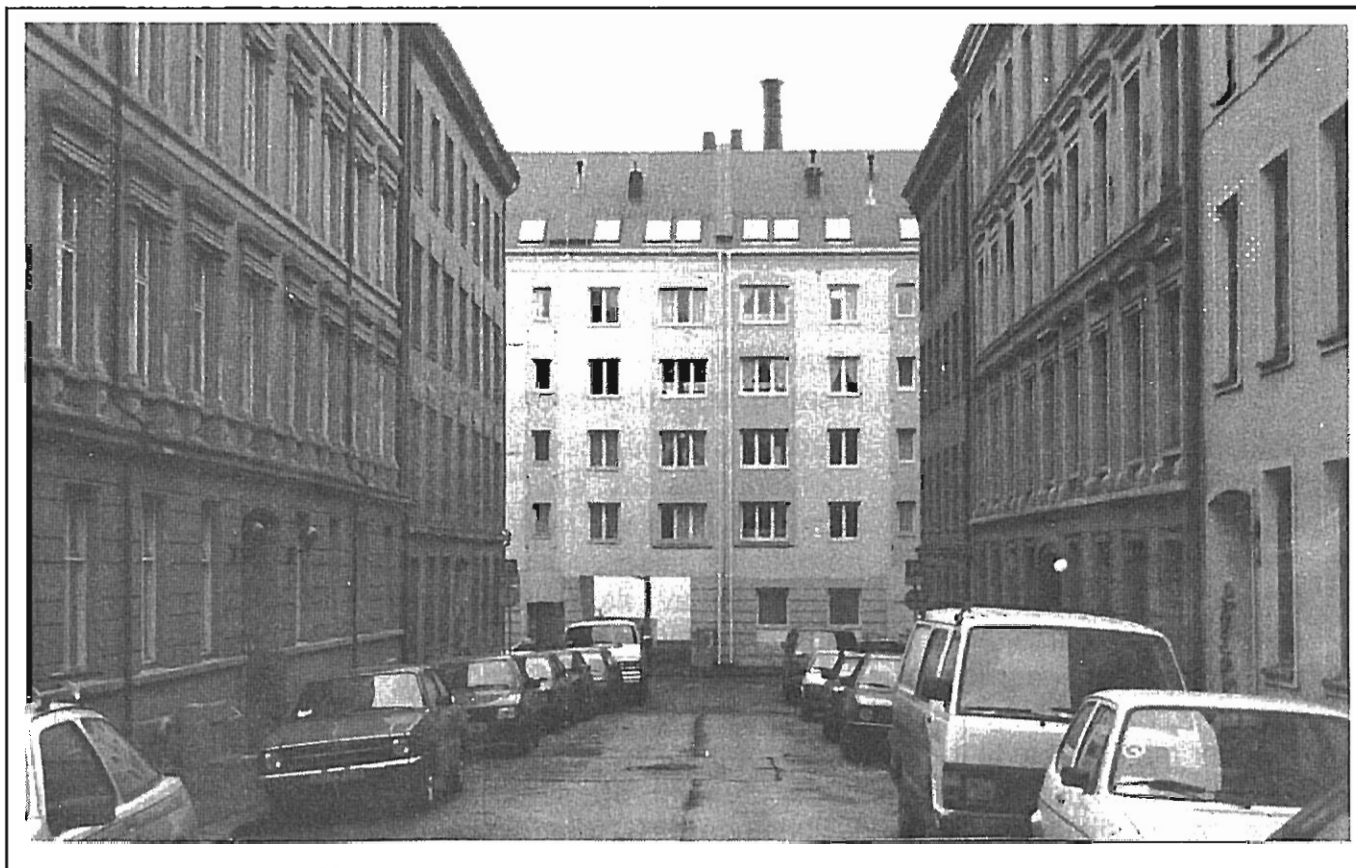
Bildet viser:Fasade fra Bjerkelundgate
