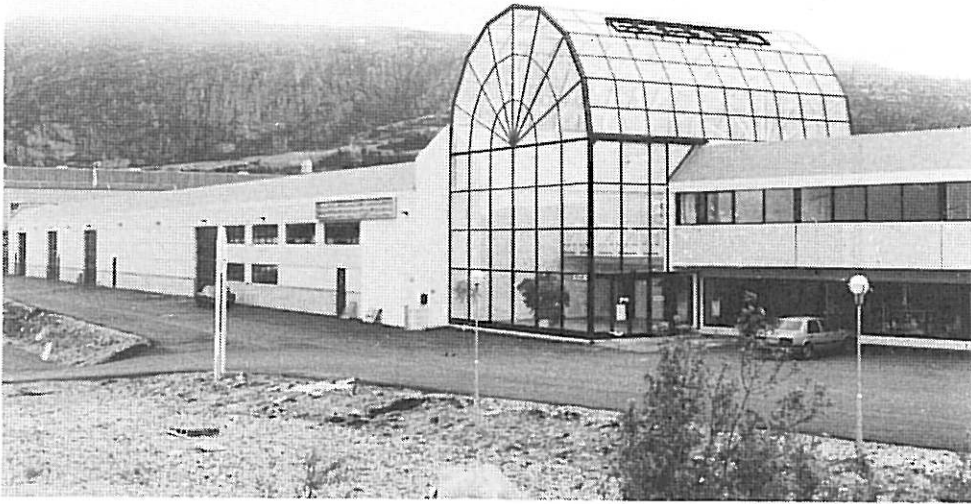
Fig. 9.3 Inngangspartier må beskyttes mot ras
