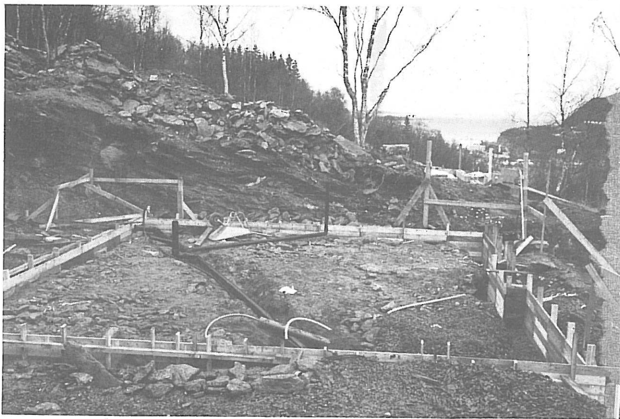
Beboerne støpte såle og satte opp grunnmurer under veiledning av den kommunale byggelederen.
