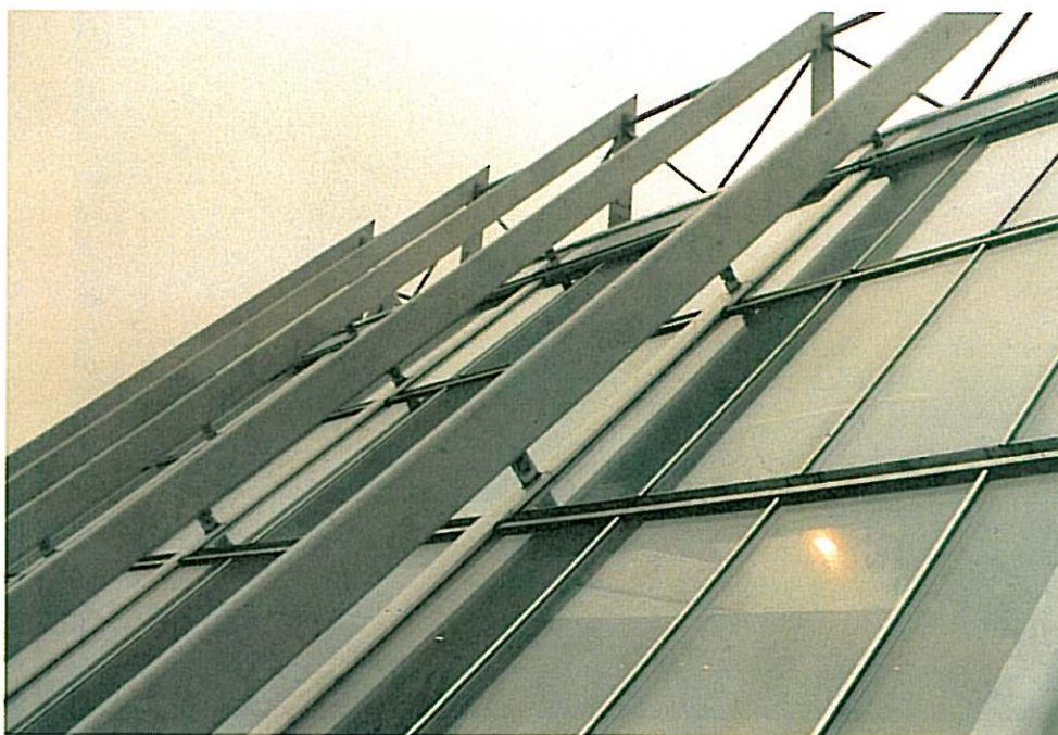
Fig. 9 Glasstak bygget opp etter taksten-prinsippet
