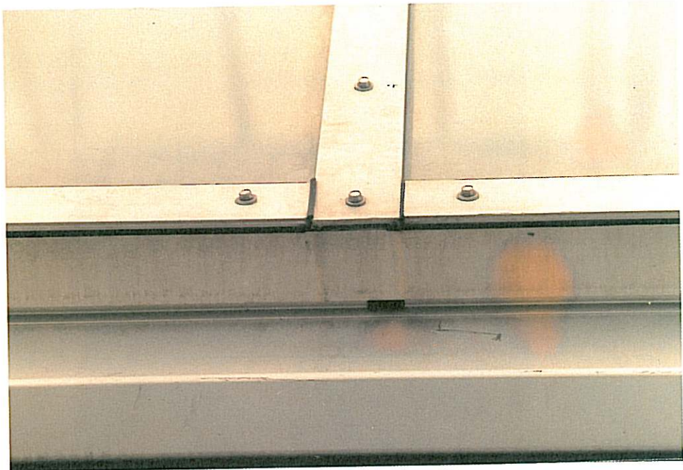
Fig. 22 Riktig utført endeavslutning av taket
