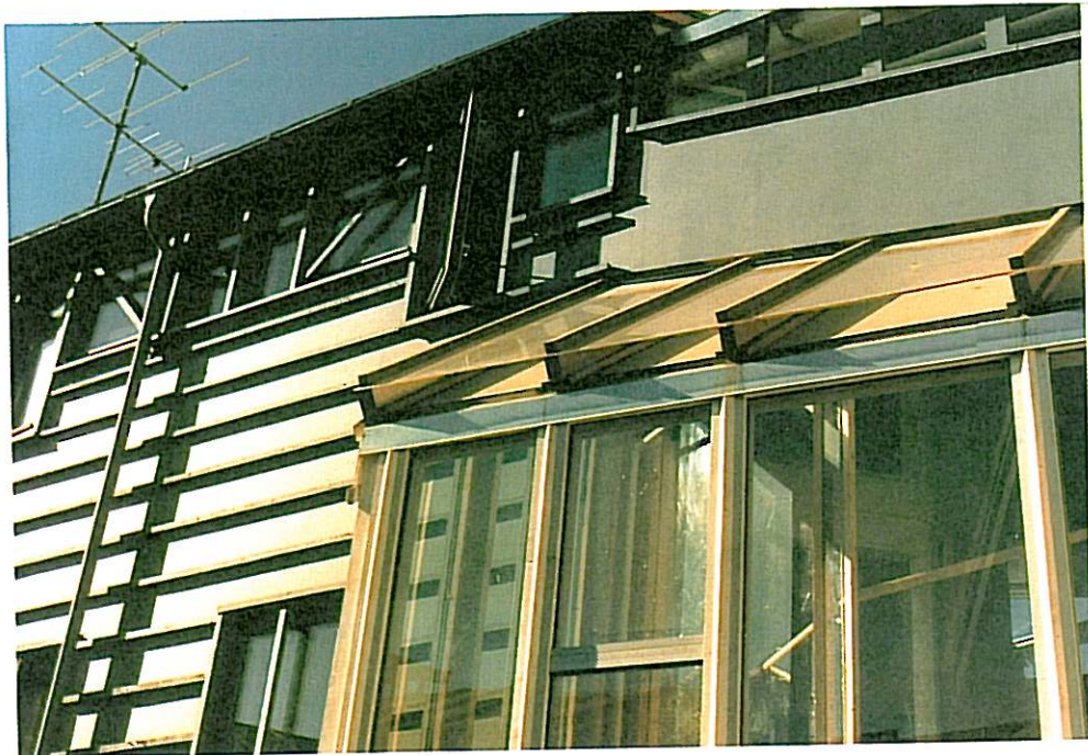
Fig. 6 Tak med beskyttelsesplate av polykarbonat
