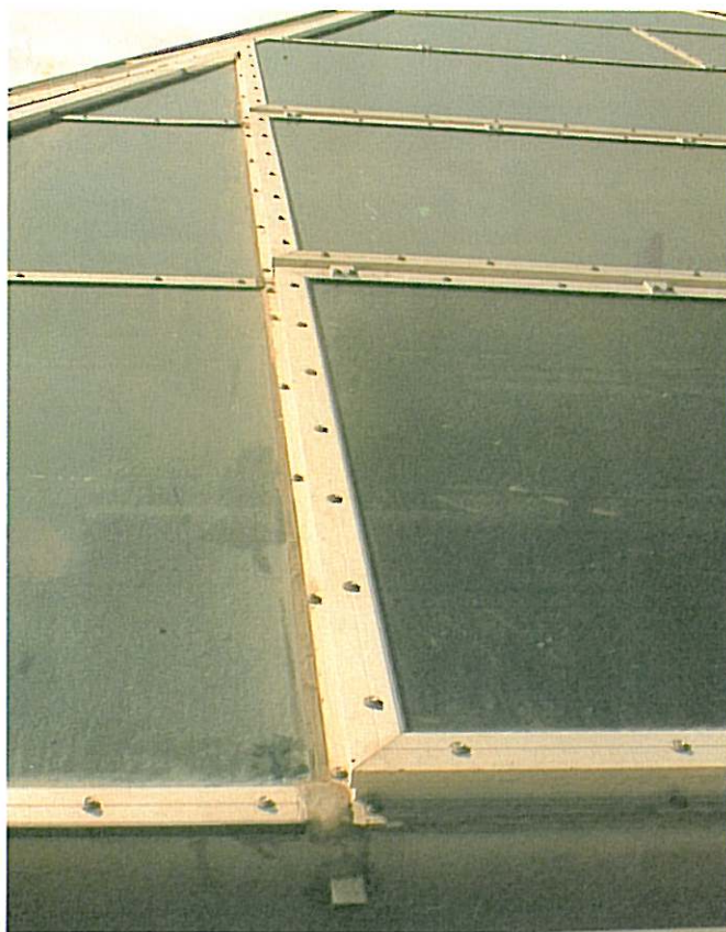
Fig. 19 Åpningsbare partier byr på problemer
