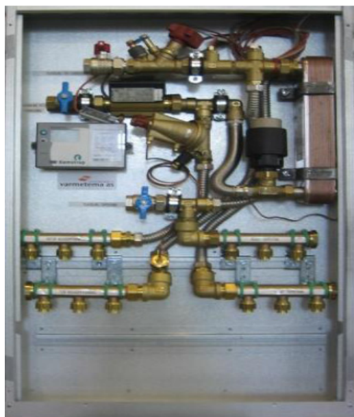
Figur 7.2 Fordelerskap m/komponenter. Kilde: Varmetema AS
