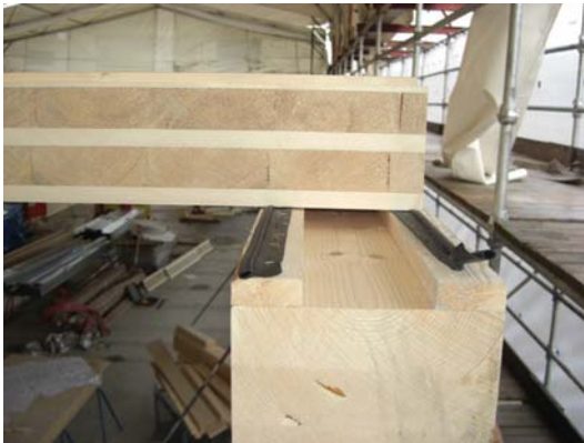
Fig. 1.3 Eksempel på montering av dekke av massivtreelement på vegg av massivtre. Foto: SINTEF Byggforsk
