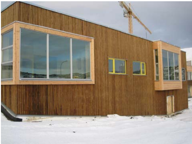
Fig. 1.6 Ny skolebygning bygd med massivtreelementer i bærekonstruksjonen (tak, vegger og dekker). Foto: SINTEF Byggforsk
