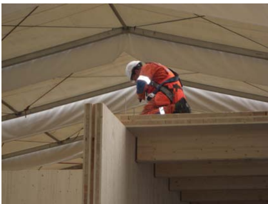
Fig. 1.4 Værbeskyttet bygging gir god beskyttelse av konstruksjon og også gode arbeidsforhold for håndverkerne. Foto: SINTEF Byggforsk
