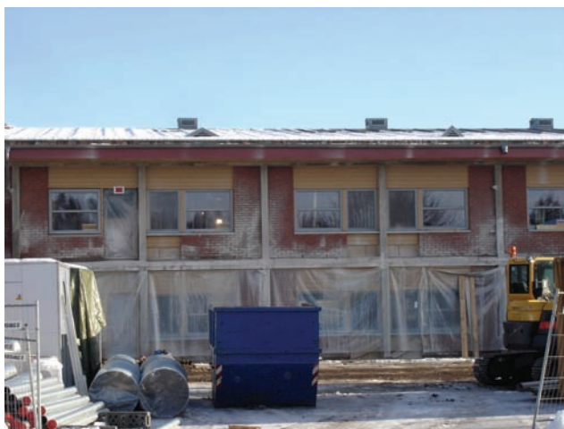
Figur 9. Dette bildet viser gjennomgående betong i en tegl/tre fasade.
