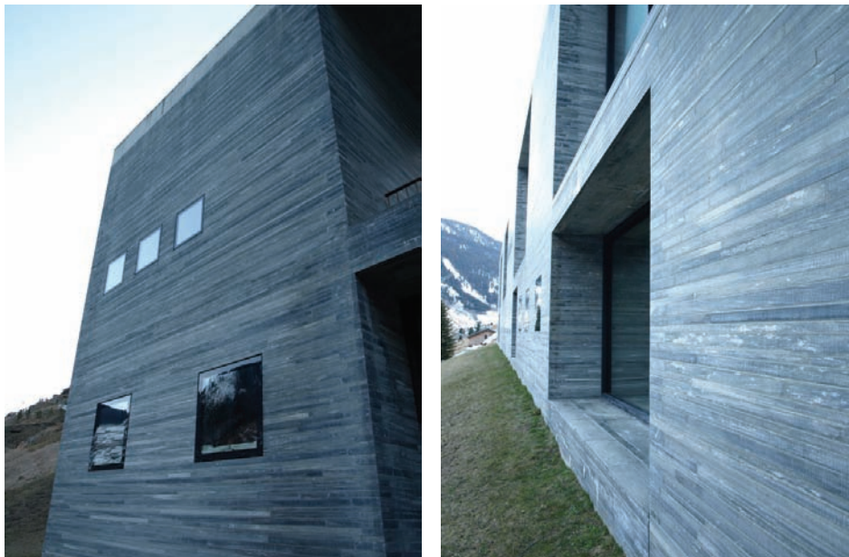
Figur 12. Eksempel på tilslutning mellom vindu og yttervegg, fra bygning i Sveits (representerer ikke nødvendigvis akseptabel byggeskikk i Norge).
