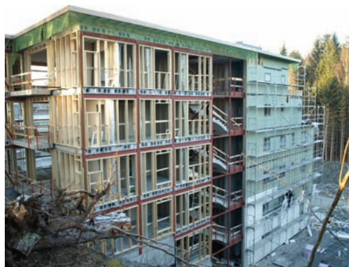
Figur 6. Bilde fra tilsvarende boligblokk som vist i figuren over, men der bærekonstruksjon og etasjeskillere fortsatt er synlig.
