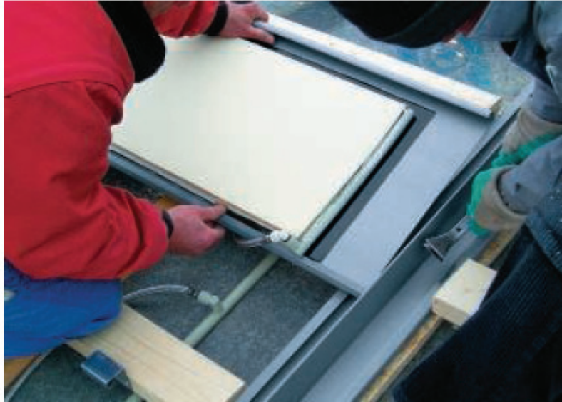
Montering av Quick-Step solpaneler.
