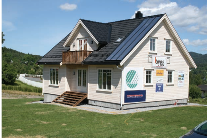
Figur 26. Mesterhus type "Ninni" med solvarmeanlegg. Foto: Mesterhus.
