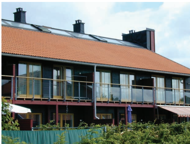
Figur 19. Lavenergiboliger i Lindås Park med solfangere på taket. Foto: Inger Andresen.
