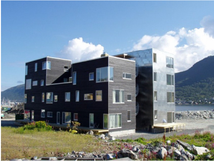
Figur 4.2.3 Strandkanten i Tromsø. En boligblokk ferdig montert og komplettert. (Kilde: Husfabrikken Steinkjer)
