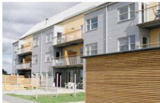
På Annestad utenfor Malmø vil byggingen fortsette med tradisjonell bygging.
