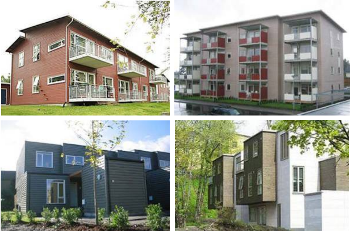
Figur 4.1.3 Forskjellige boligbygg basert på moduler fra Moelven ByggModul.
