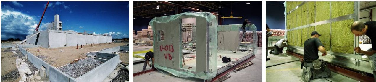
Figur 4.3.2 Fundamenteringen er i utgangspunktet "kjellerløs" (bildet til venstre). De andre bildene viser montasjen i produksjonshallen.
