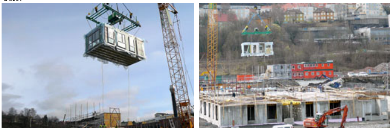
Figur 5.3.1 Figuren viser monteringen av de første seksjonene i Kværnerbyen i Oslo. (Kilde OBOS).
