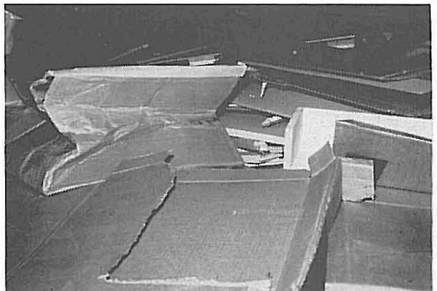
Kryperommet brukt som lagerplass
