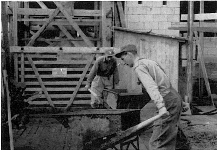
Fig. 1. Arbeidsstudier på Kalbakken 1955 ved betongtrilling og bruk av planheis.
