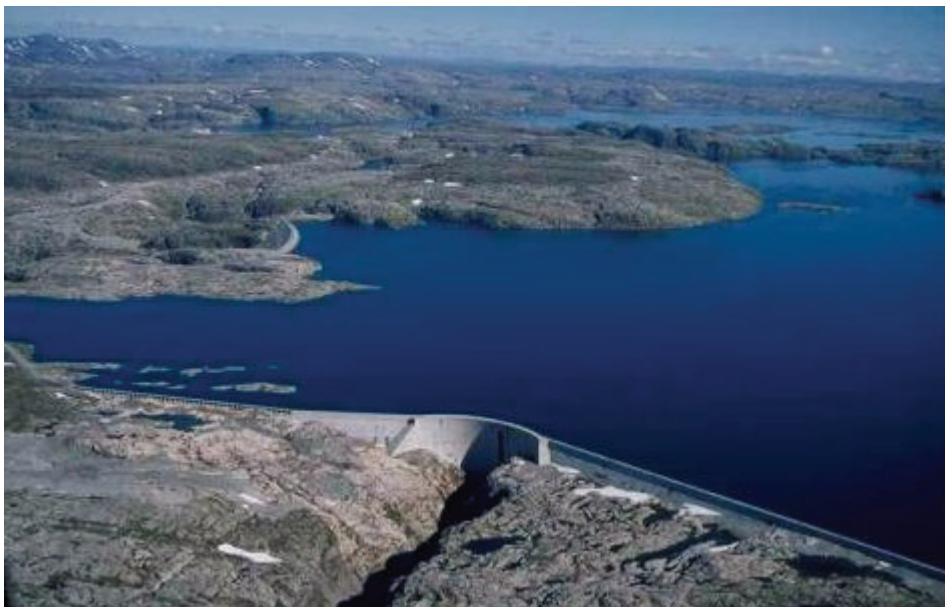
Figure 5-2. Førrevassdammen completed. (photo; Statkraft, www.energifakta.no )
