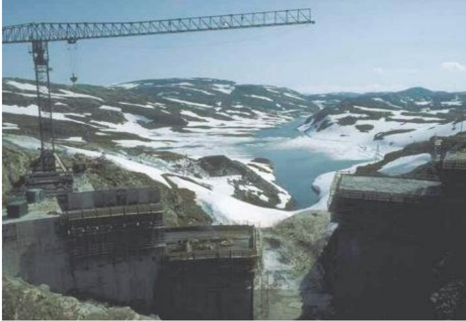
Figure 5-1. The construction of Førrevassdammen. (photo; Statkraft, www.energifakta.no )
