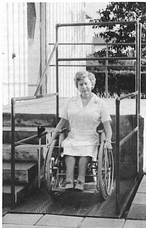
Fig. 5. Lyftplattan LIFT. Som bildet viser er det nødvendig med rom for nedgravning av "mekanismen" til denne løfteplaten. Plassbehovet for montering ellers er 1,15 x 1,40 m. LIFT beveger seg 1 m pr. minutt.
