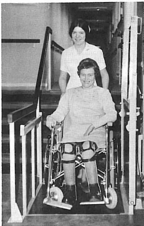
Fig. 4. Monolift P 2. Plattformen på denne trappeheisen, som er beregnet for transport av rullestoler, kan tilpasses individuelt. Min. bredde av trappen må være 1,10 m.
