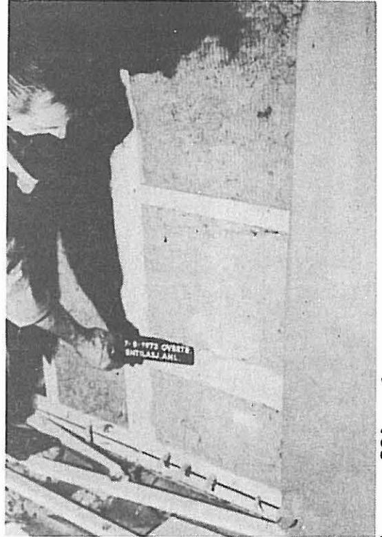
Fig. 6. Helt våt og nedfrossen dytt om vindu. Vindu 60x60.
