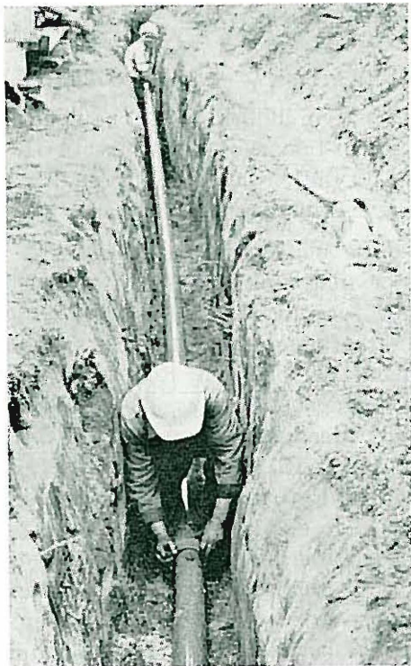
Fig. 2. Trykkrør i PVC brukes meget i 100 til 200 mm diametre til hovedledningsanlegg.
