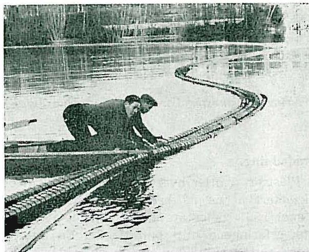
Fig. 3. PEH sjøledninger brukes langs kysten hvor de blir utsatt for store påkjenninger.
