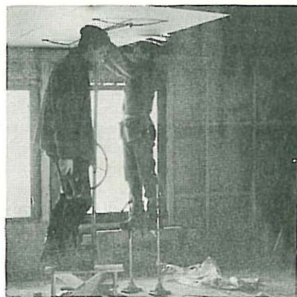
Fig. 2. Platejekk reduserer tidsforbruket med 20 % ved montering av plater i tak.
